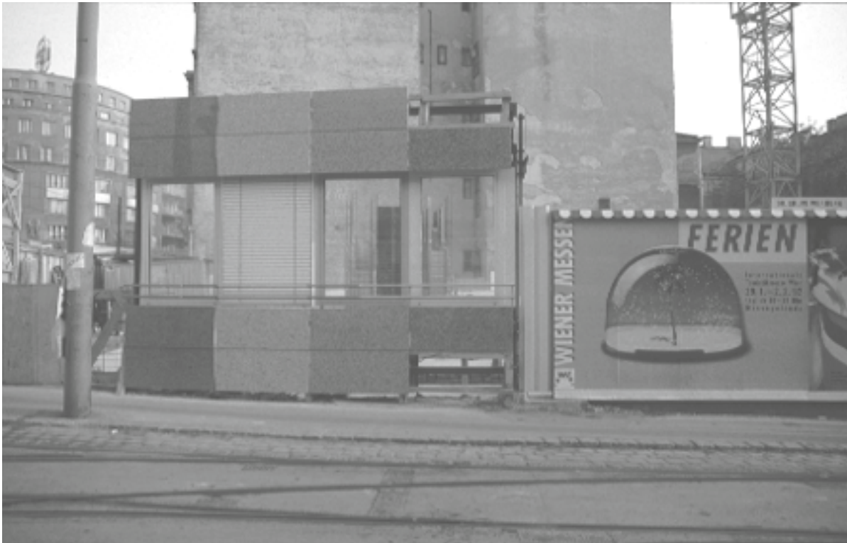
Abb. 14 1:1-Proben mit der Bemusterung auf der Baustelle.
