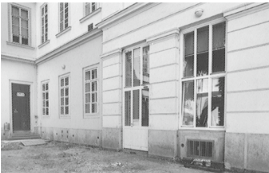
Abb. 52 Hofseitiger Eingang des Raumexperimentierlabors.
