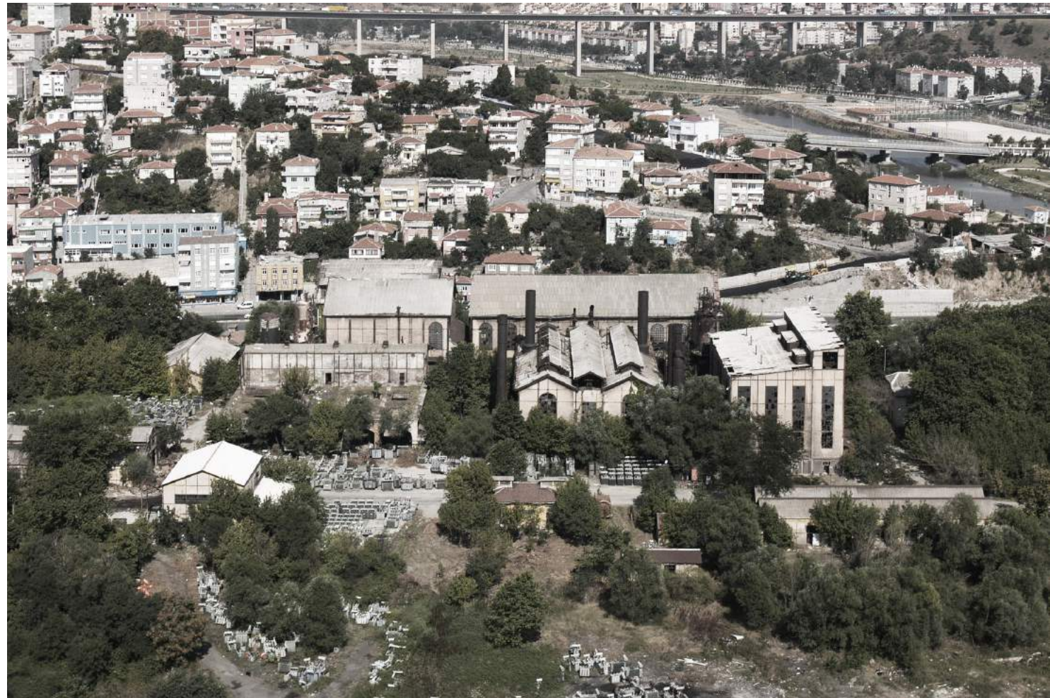
ABB.05 Luftbild 2004 - vor der Revitalisierung
