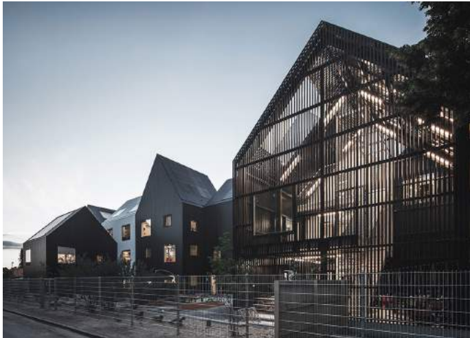
1 - DÄNEMARK, Frederiksvej Frederiksvej Kindergarten
