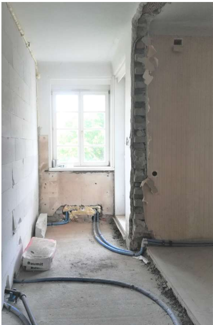
Abb. 40: Boschstraße 1-3, Stiege 30, Top 13 Bestehender Holzboden wird erhalten
