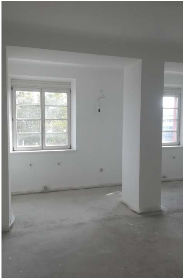
Abb.59: Estrich ist getrocknet und die Anstricharbeiten sind fertig
