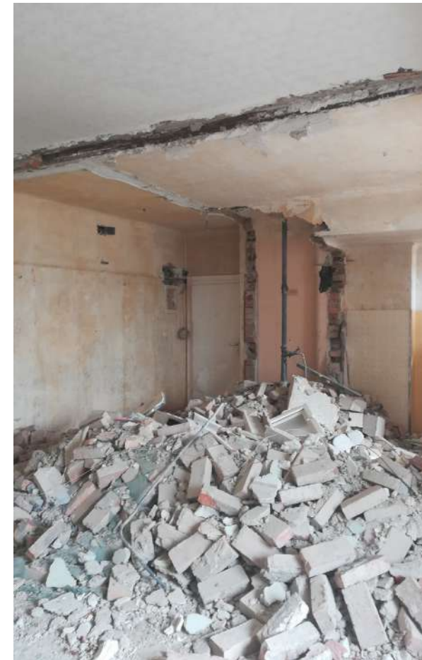
Abb.58: Stand während der Abbrucharbeiten
