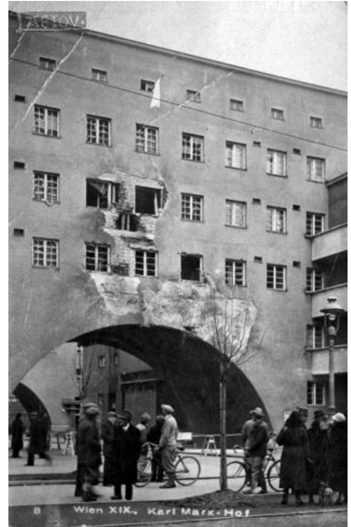
Abb. 32: Beschädigter Karl-Marx-Hof nach den Februarkämpfen 1934
