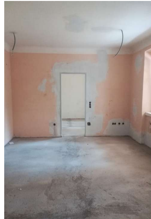
Abb.71: Fertiggestellter Estrich
