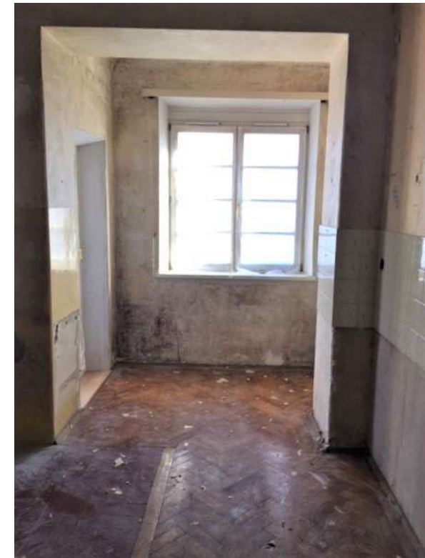
Abb.51: Boschstraße 5, Stiege 36, Wohnung 6, Bestandsboden: Parkett und Fliesen
