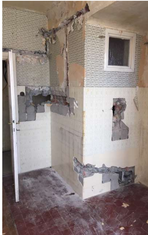
Abb.57: Boschstraße 5, Stiege 36, Wohnung 6, alte Haustechnik ist demontiert
