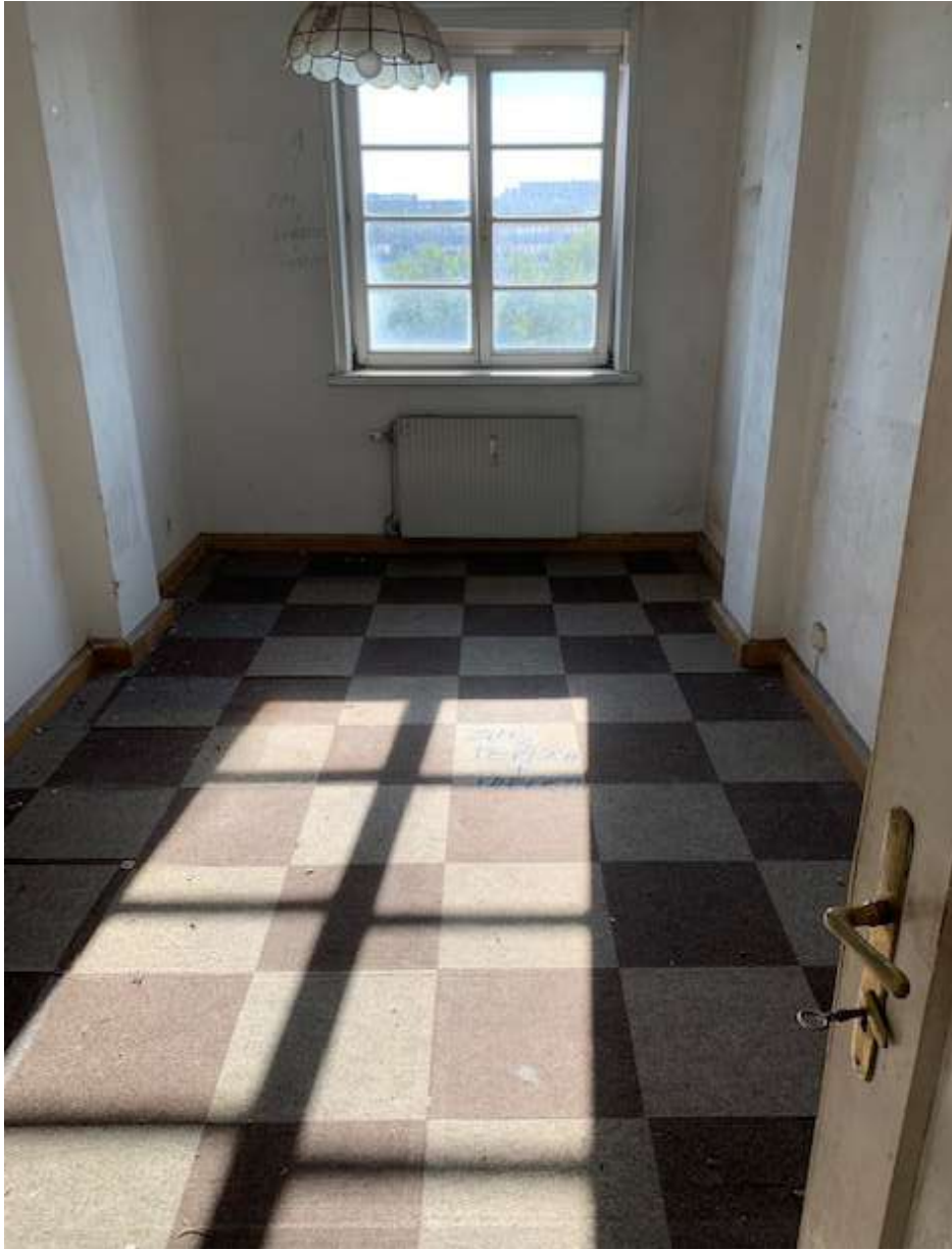
Abb.47 und 48: Vergleich Wohnung 8 vor und nach der Um- bauarbeiten
