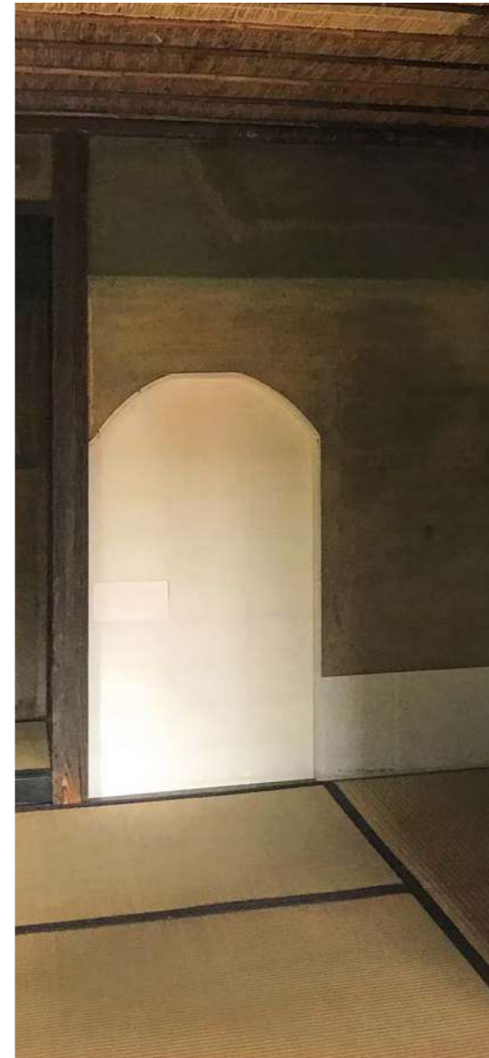
155 Katō-guchi mit rundem Sturz; Villa Katsura, Kyōto.
