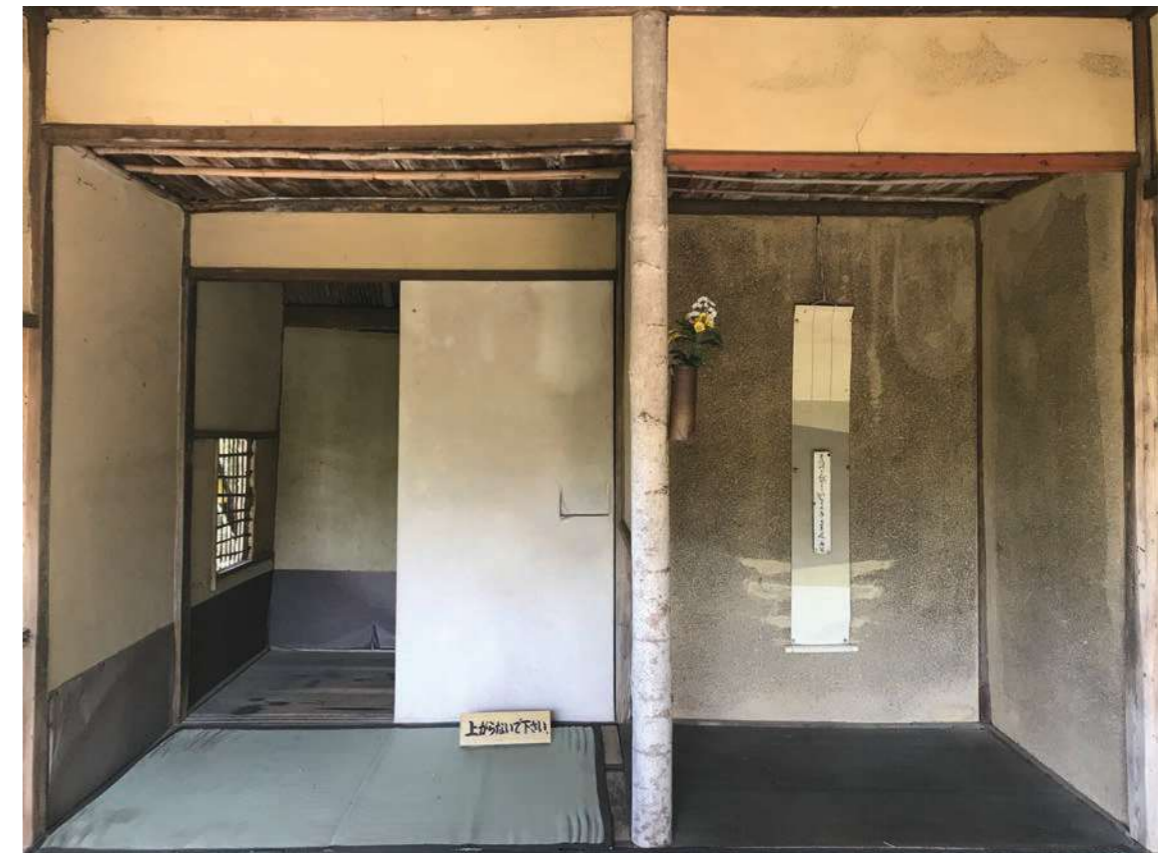
258 Der Blick vom Gästeeingang; auf der linken Seite bildet die helle Fläche der Gastgebertüre einen visuellen Kontrast zur dunkel gehaltenen tokonoma -Nische; die Ärmelwand sode-kabe bleibt aus dieser Position fast gänzlich verborgen.
