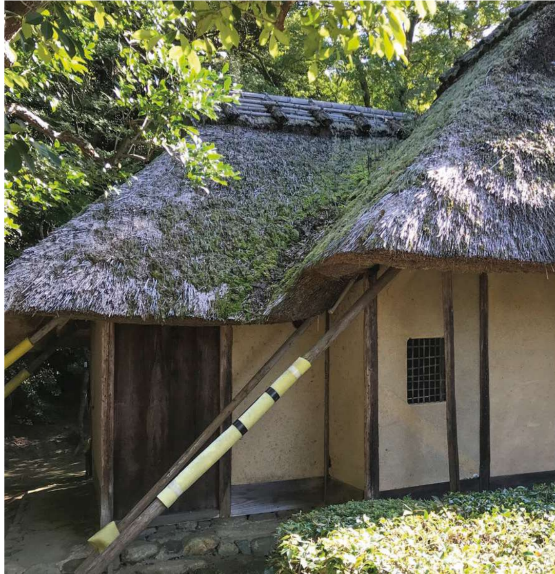
256 Der Gastgeber betritt das Gebäude durch die dunkle Holztüre, die in den Servicebereich mizuya führt.
