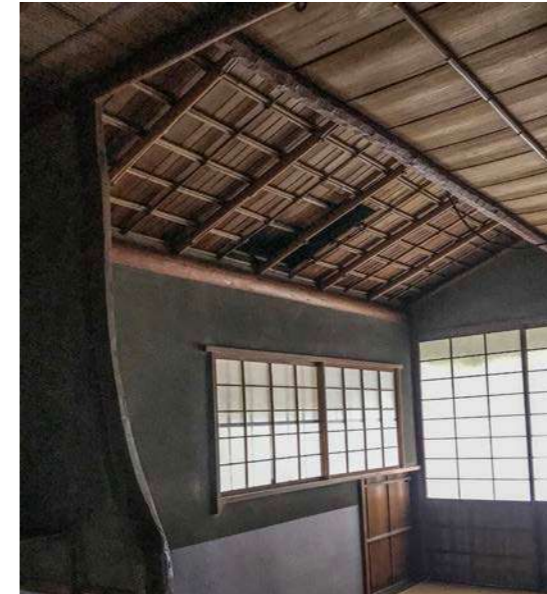
163 Raumzonierung mittels unterschiedlicher Deckengestaltung: über dem Gästeeingang dient die Dachuntersicht als Decke, der Bereich des Gastgebers weist die niedrigste Raumhöhe auf und über dem Gästebereich befindet sich eine höhere, ebenfalls horizontale Decke aus Holzbrettern; Kōrin-in (Daitoku-ji-Subtempel), Kyōto.
