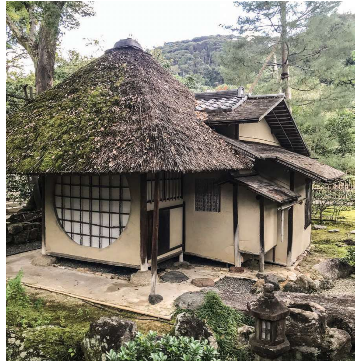
166 Unterschiedliche Dachgestaltung der verschiedenen Innenbereiche, Iho-an-Teehaus; Kodaiji-Tempel, Kyōto.
