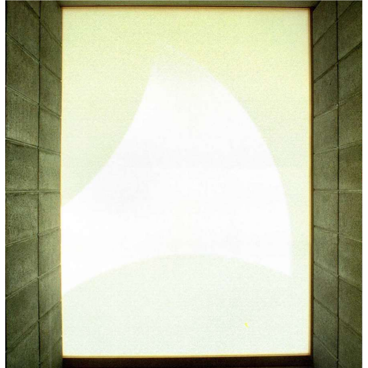
119 Innenansicht mit milchig-weißem Glasfenster mit Ginkgoblatt-Motiv, Boden und Wände bestehen aus polierten Betonsteinen; Block Tea House.
