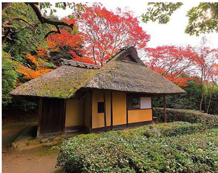
225 Obere Ebene; Blick auf das Teehaus.
