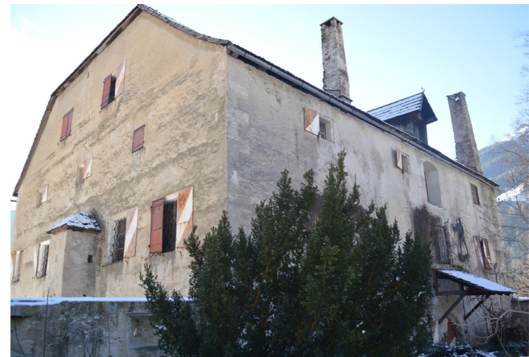
Abb 78: Schloss Großkirchheim – Südbau Nordfassade
