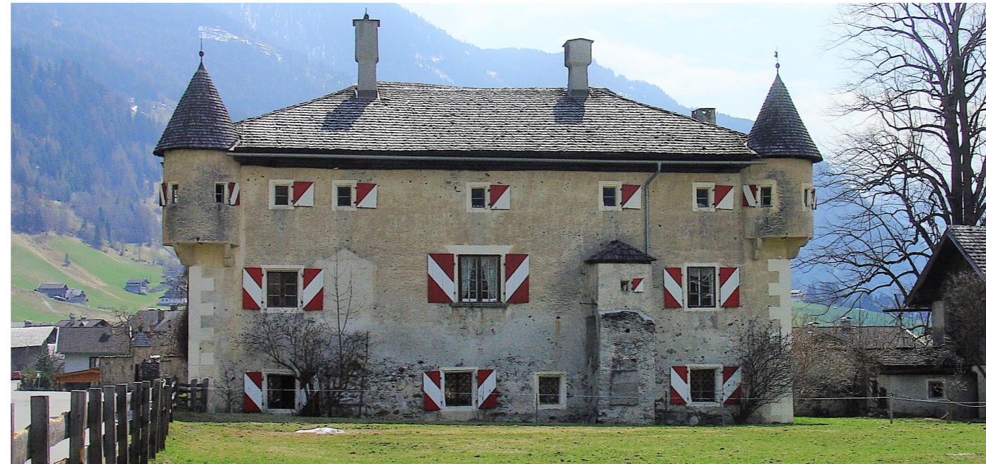
Abb 58: Nordwest-Fassade des Schlössls Großkirchheim
