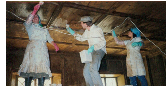
Abb 55: Sanierungsarbeiten im Schloss Großkirchheim – Nordbau im Jahre 1983
