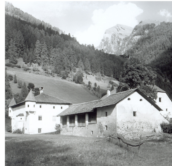
Abb 60: Schlossanlage Großkirchheim vor der Sanierung im Jahre 1983
