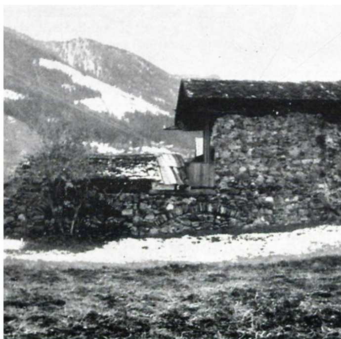
Abb 50: Mauerreste der Ruine des Alten Schlosses
