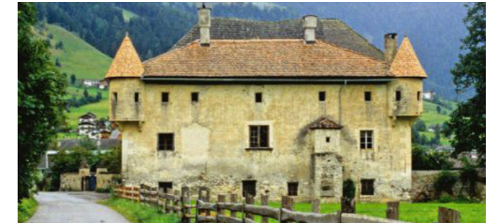
Abb 54: Schloss Großkirchheim – Nordbau vor der Sanierung im Jahre 1983
