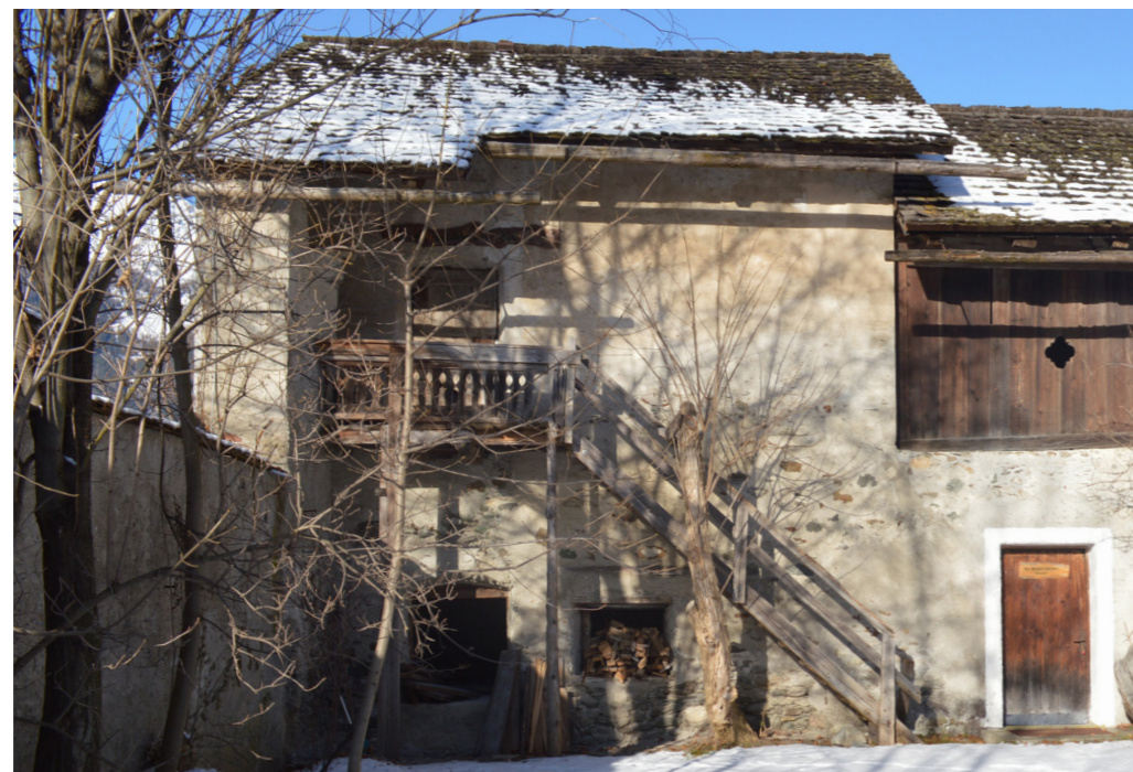
Abb 69: Ehemaliges evangelisches Bethaus-Südfassade
