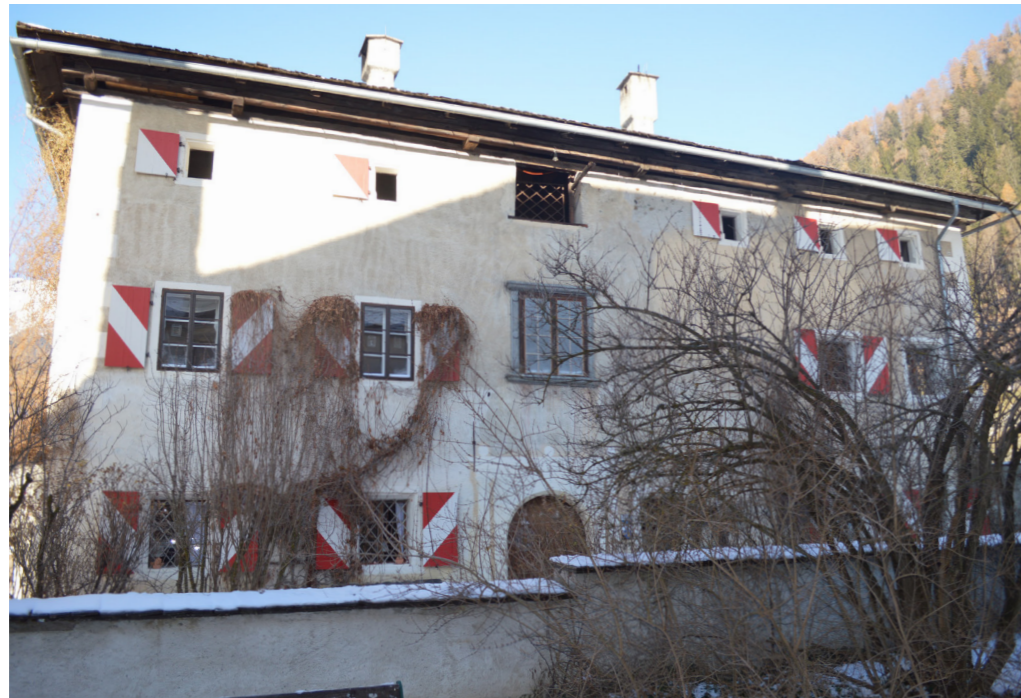
Abb 65: Schloss Großkirchheim – Nordbau Südfassade
