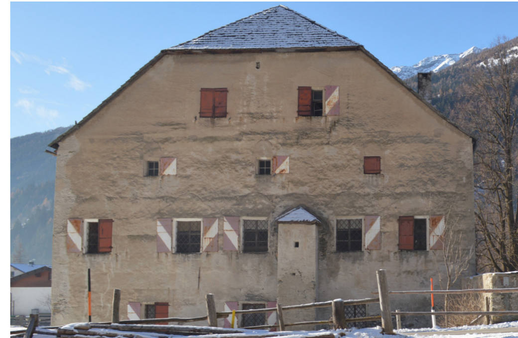
Abb 76: Schloss Großkirchheim – Südbau Ostfassade
