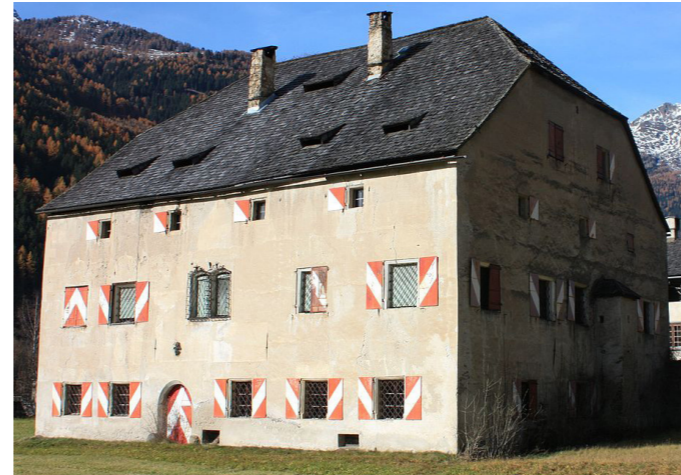
Abb 21: Schloss Großkirchheim – Südbau
