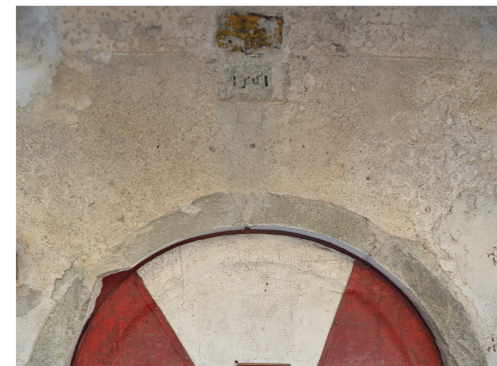
Abb 62: Datum des Baubeginns über den Nordtor des Südbaues in Stein gemeißelt
