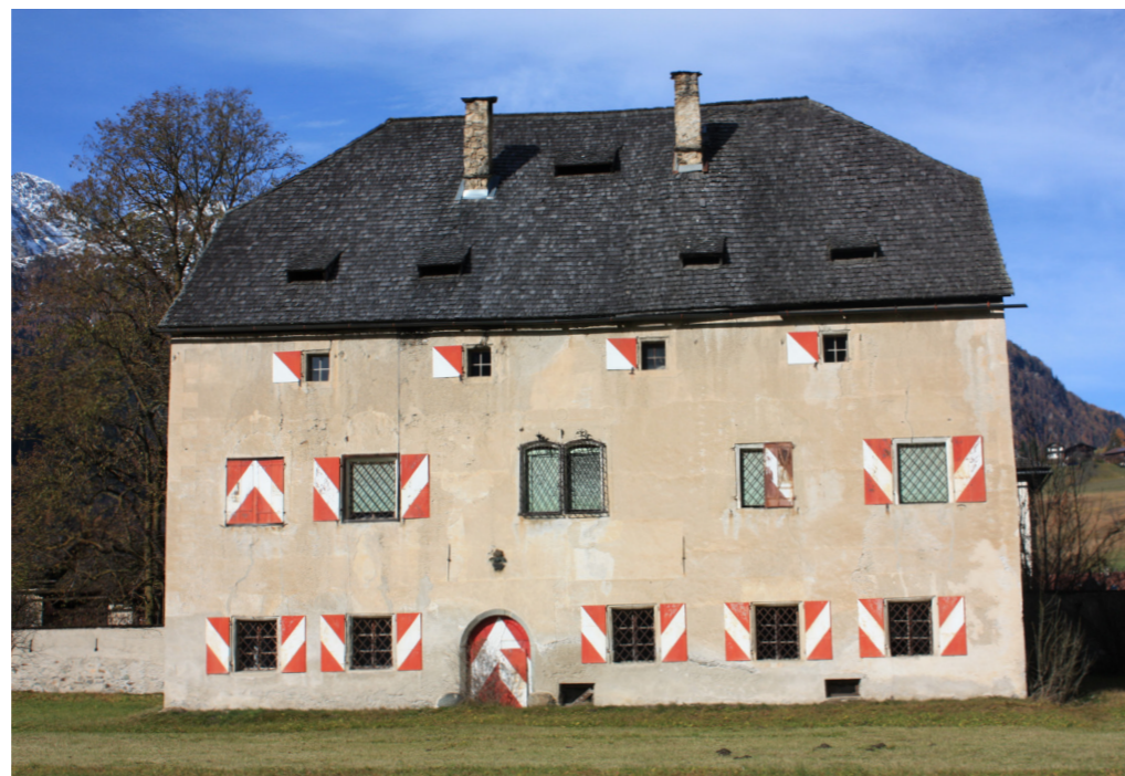
Abb 77: Schloss Großkirchheim – Südbau Südfassade
