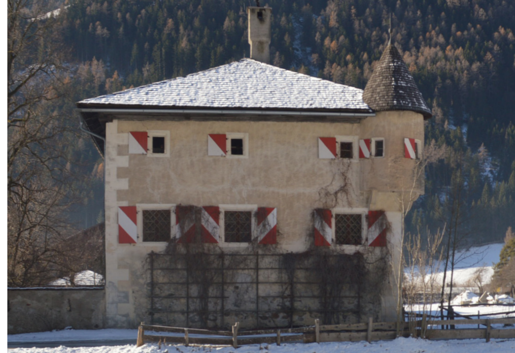
Abb 64: Schloss Großkirchheim – Nordbau Ostfassade
