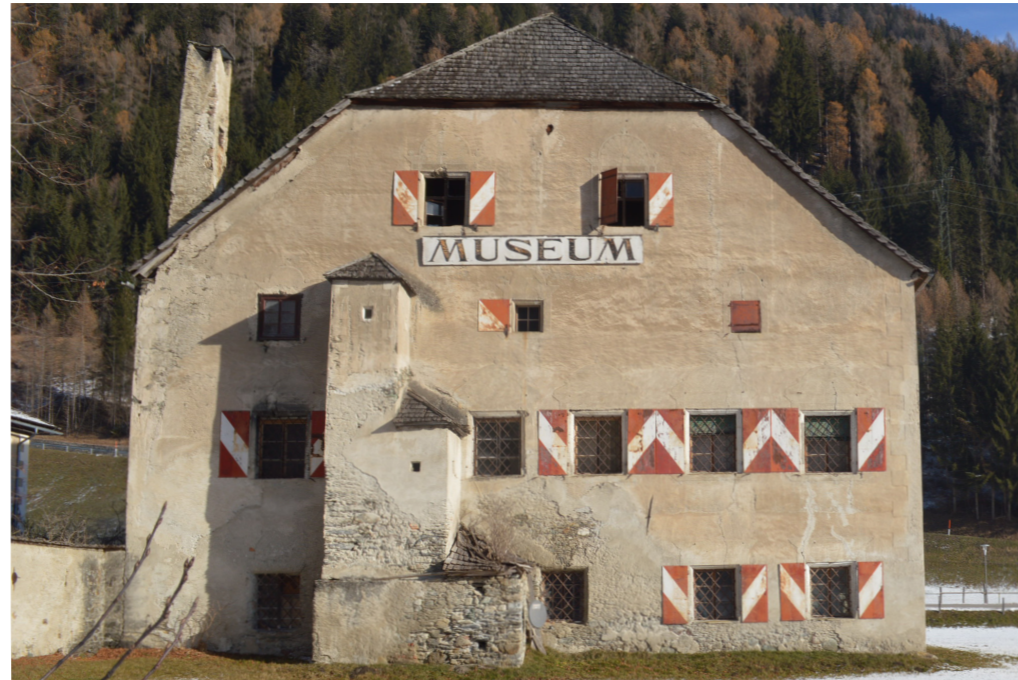
Abb 75: Schloss Großkirchheim – Südbau Westassade
