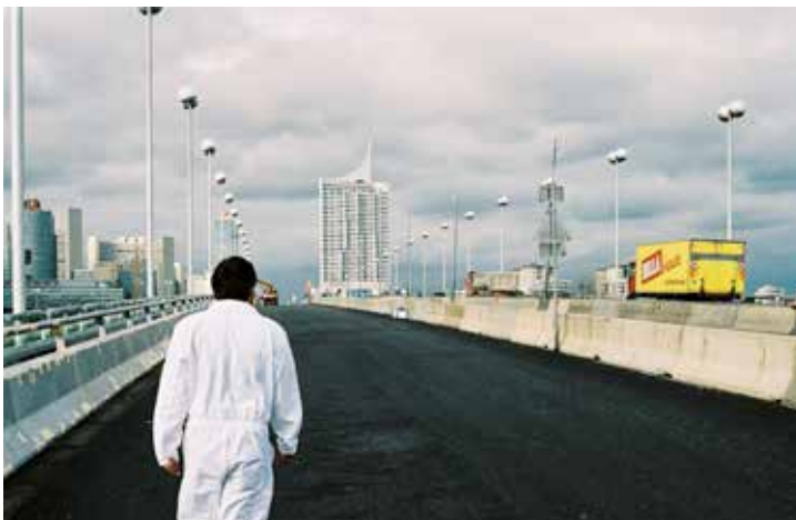
Einsatz auf der Reichsbrücke während deren Renovierung, der in der Nacht mit der MA 29 fortgesetzt wurde.
