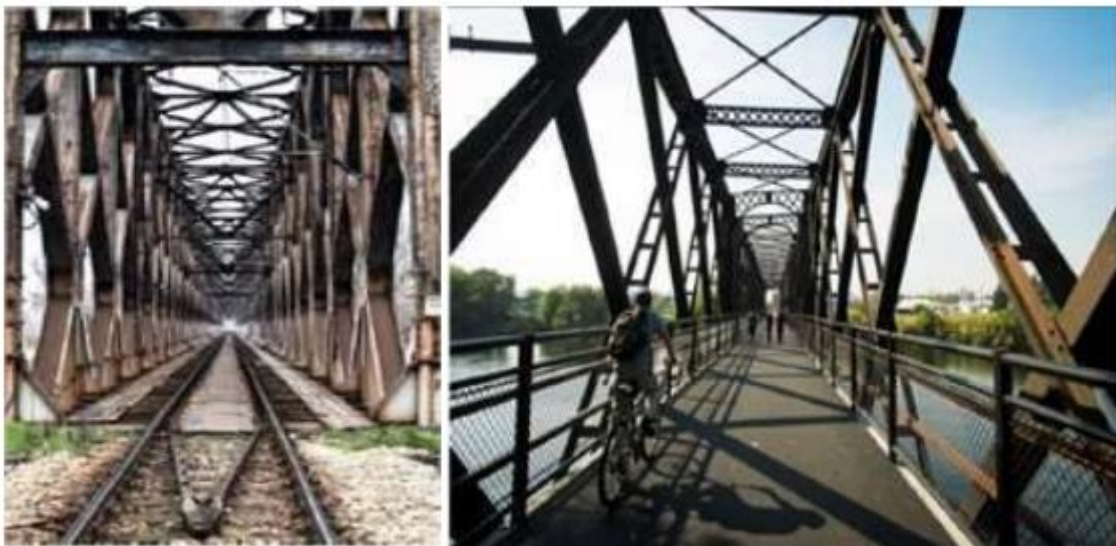
Abbildung 47: Bestehende (links) und mögliche (rechts) Verwendung der Brücke in Belgrad. [8]
