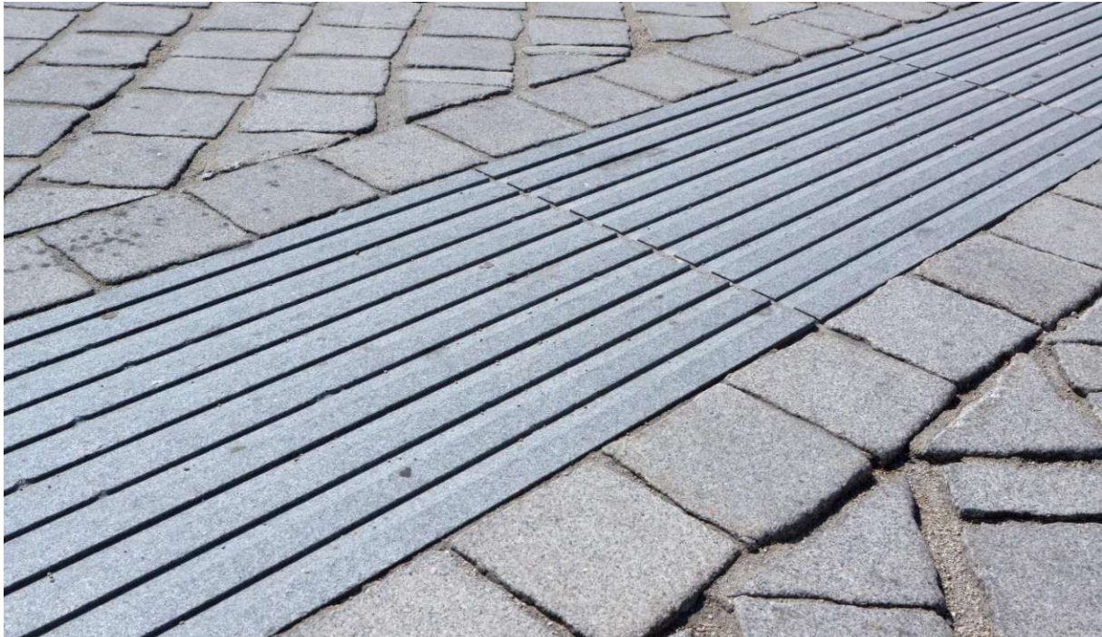
Abbildung 11 Leitlinien als Platten in eine Pflasterung eingefügt
