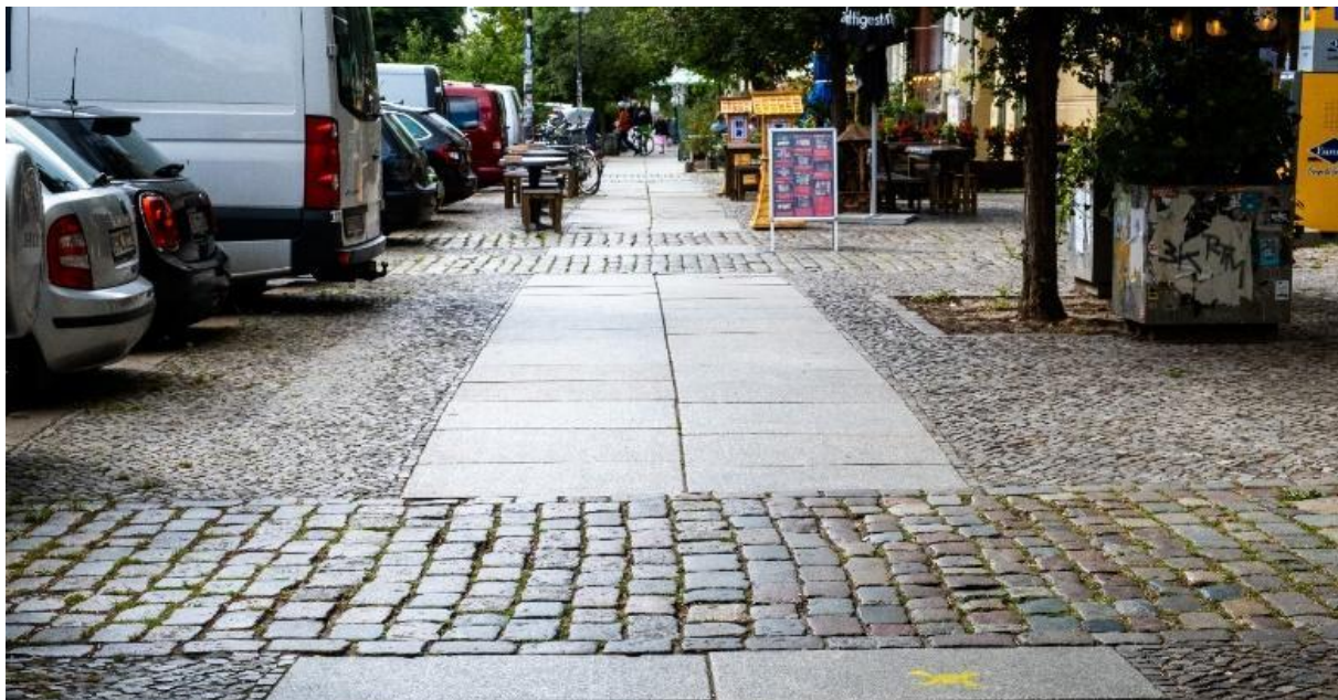
Abbildung 45 Klassischer Aufbau und Zonierung eines Berliner Gehsteigs
