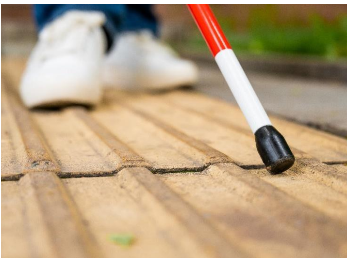
Abbildung 8 Detailansicht einer Stockspitze auf einem taktilen Leitsystem
