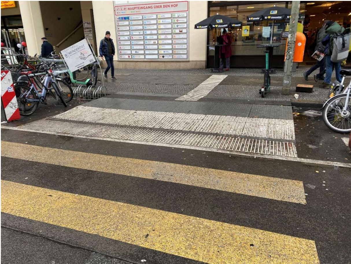
Abbildung 43 Neugeschaffene Querungsstelle mit taktilen Bodenindikatoren Quelle: Eigene Aufnahme.
