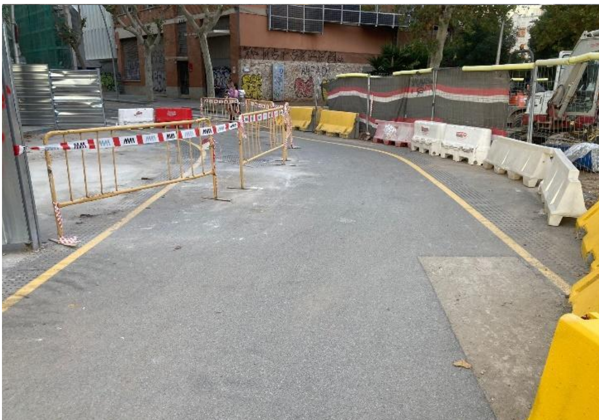
Abbildung 32 Kreuzungsbereich C/ de la Ciutat de Granada und C/ dels Almogàvers mit Einschränkungen durch Baustellenabsperungen ohne Adaption des taktillen Leitsystems Quelle: Sophie Hofbauer.
