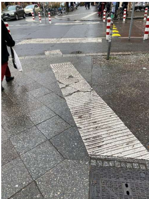
Abbildung 51 Detailansicht Bodenleitsystem im Kreuzungsbereich Bergmannstraße/Nostizstraße Quelle: Eigene Aufnahme.
