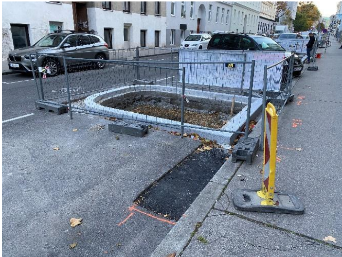
Abbildung 59 Baustelleabsicherung im Bereich eines neuen Baumstandortes
