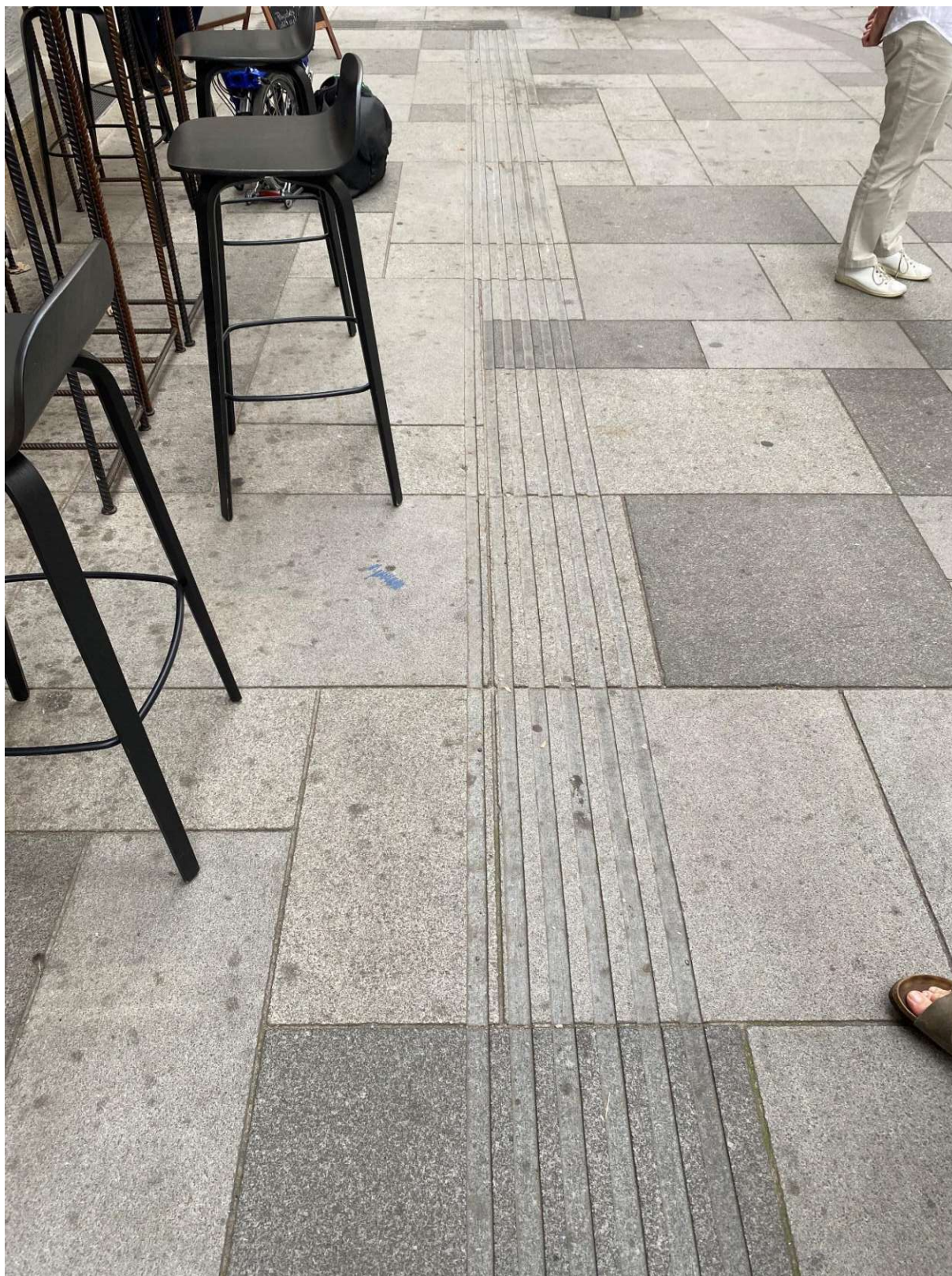
Abbildung 18 Ungesicherter Schanigarten an der Hausfassade und ein zu geringer Abstand zu den eingefrästen Leitlinien
