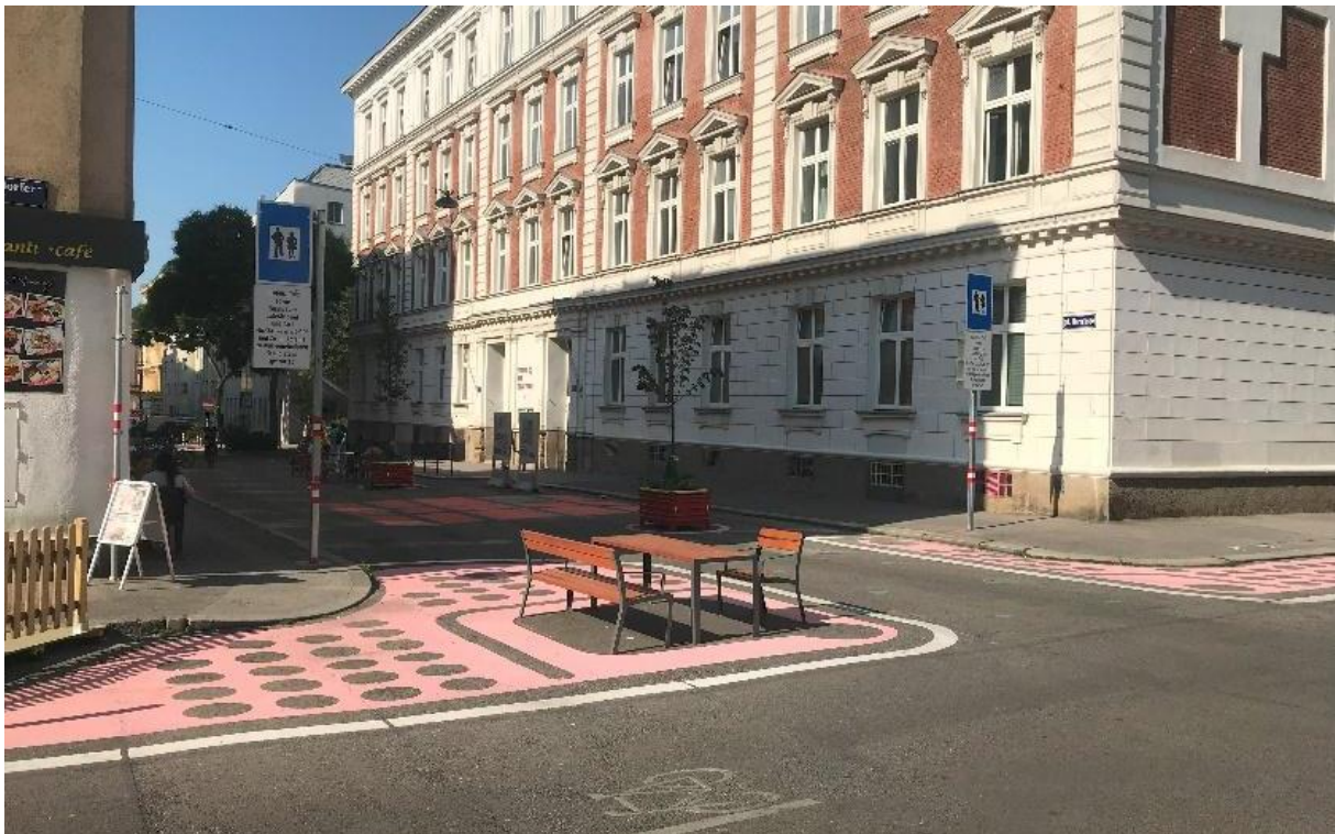
Abbildung 56 Kreuzungsbereich Herzgasse/Pernerstorfergasse mit temporären Gehsteigvorziehungen und der temporären Fußgängerzone im Hintergrund Quelle: Eigene Aufnahme.
