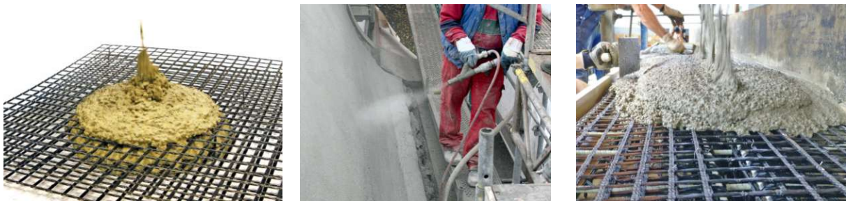
Abb. 2.12: Einbau von frischem Textilbeton, entnommen aus [45] und [44].
