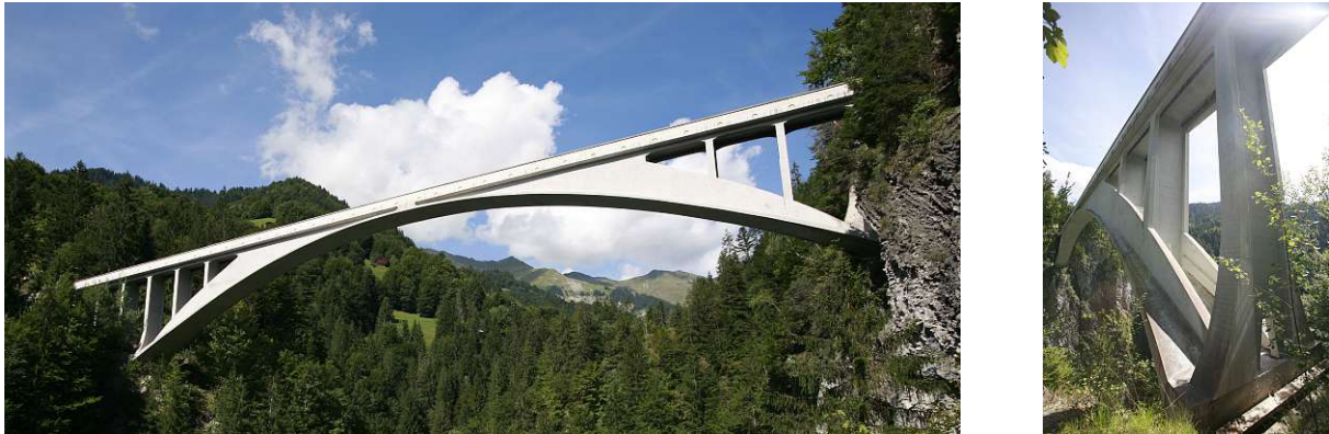
Abb. 2.1: Salginatobelbrücke, geplant von Maillart 1929, entnommen aus [12] und [13].
