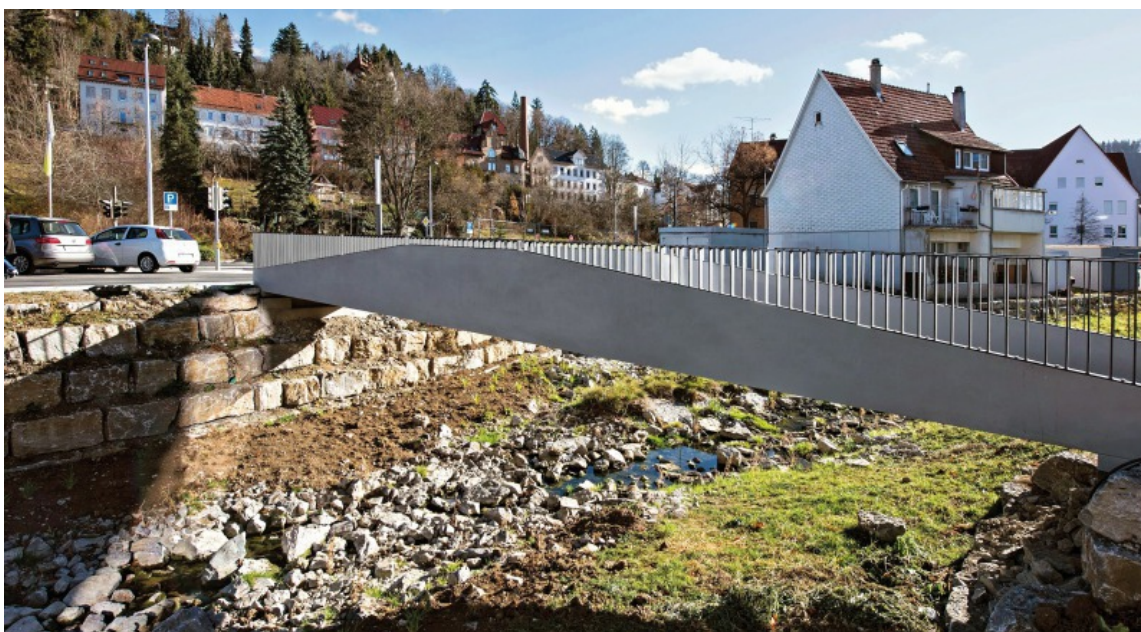
Abb. 2.4: Fuß- und Radwegbrücke aus Carbonbeton in Albstadt-Ebingen, entnommen aus [32].
