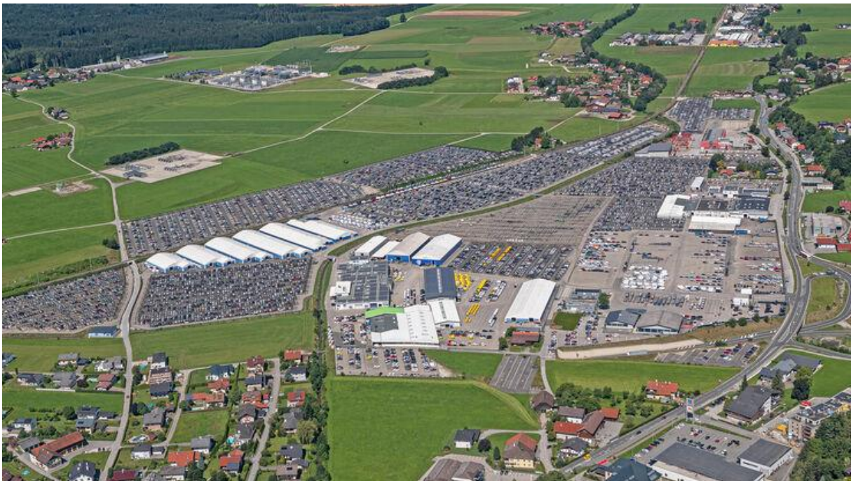
Abb. 1: Autotransportunternehmen in Straßwalchen. Quelle: Lagermax Autotransport GmbH o.J.
