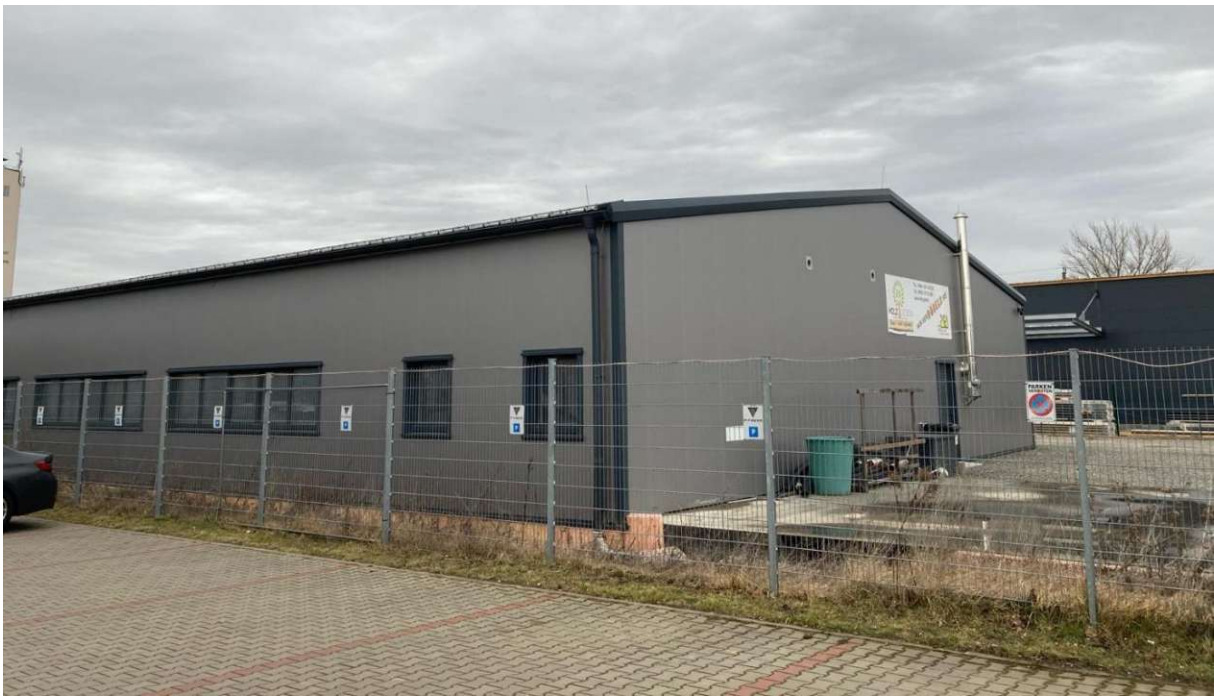
Abb. 17: Flachbau in einem Betriebsgebiet. Quelle: eigene Aufnahme
