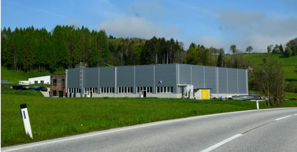
Abb. 19: Betriebshallengebäude. Quelle: eigene Aufnahme
