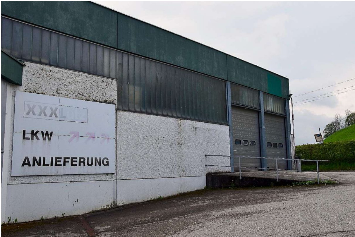
Abb. 28: Leerstehendes Logistikzentrum. Quelle: eigene Aufnahme
