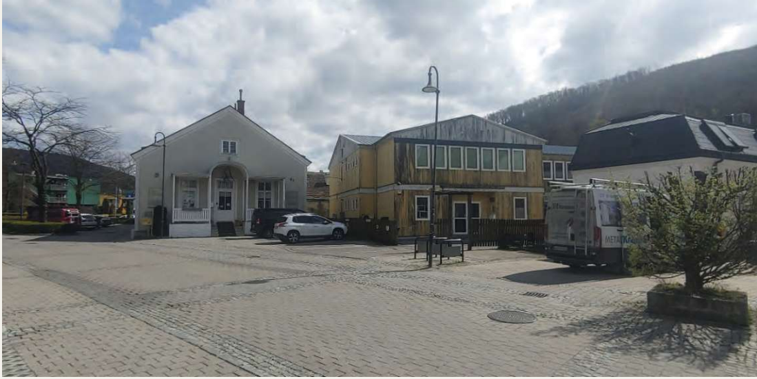
Abb. 37: Temporäres Schulgebäude (gelb) in Purkersdorf (Eigene Fotografie)
