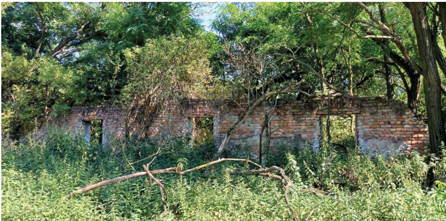
Abb. 72: Zugang über die verwilderte Meierei- mit einem Gebäude als Ziegelsteinressource (eigene Fotografie)
