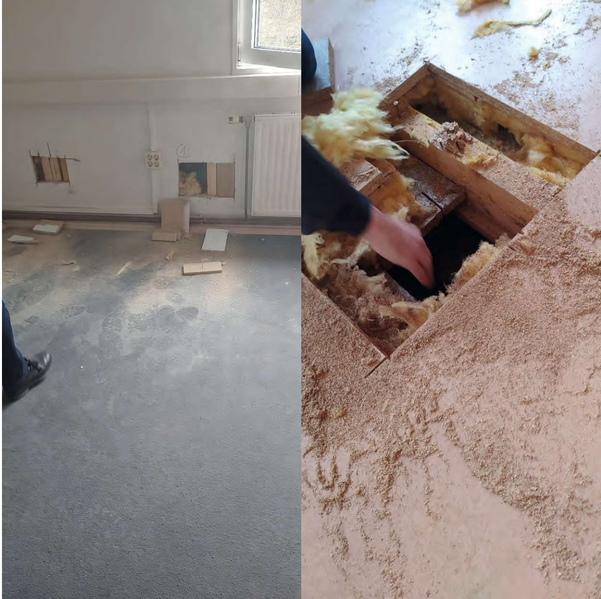
Abb. 79: Fotografien der begutachteten Konstruktion (Eigene Fotografien)
