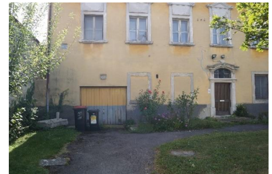
Abb. 3.2.12: Eingebaute Garage, Pfarrhaus Winden am See.
