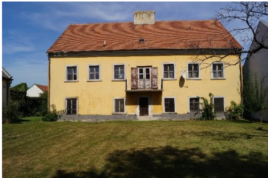
Abb. 1.0.5: Pfarrhaus Winden am See, Südwestfassade.
