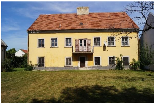
Abb. 3.1.7: Südwestfassade, Pfarrhaus Winden am See.
