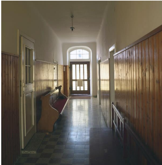
Abb. 3.1.10: Gang beim Eingangsbereich, Raum Nr. 1, Pfarrhaus Winden am See.
