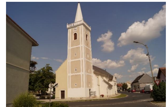
Abb. 3.3.19: Kirche in Leithaprodersdorf.
