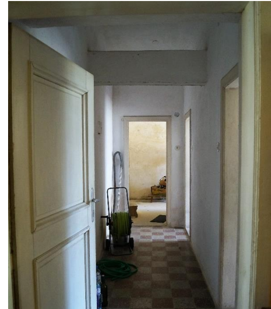
Abb. 3.1.14: Gang, Raum Nr. 4, Pfarrhaus Winden am See.
