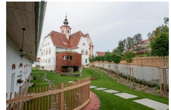
Abb. 4.1.9: Anbau Küche mit Fassade aus Cortenstahl, Restaurant Riederer, ehemaliger Pfarrhof, Sankt Andrä im Sausal.
