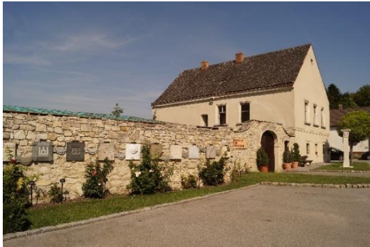
Abb. 3.3.6: Ehemaliger Pfarrhof in Kaisersteinbruch.
