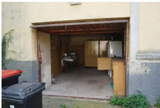
Abb. 3.1.13: Eingebaute Garage an der Nordostfassade, Raum Nr. 3, Pfarrhaus Winden am See.
