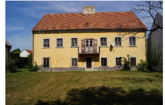
Abb. 3.2.11: Zugebauter Balkon, Pfarrhaus Winden am See.
