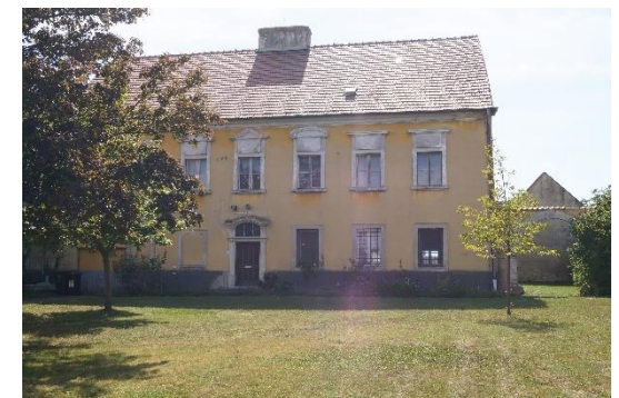
Abb. 3.1.5: Nordostfassade (Hauptfassade), Pfarrhaus Winden am See.
