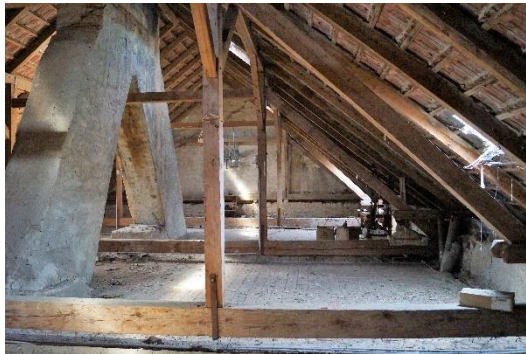
Abb. 3.1.30: Dachraum mit Kamine, Pfarrhaus Winden am See.
