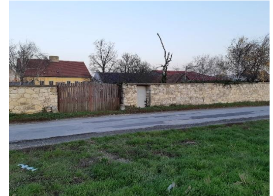
Abb. 4.4.4: Grundstück des Pfarrhofs von der Raiffeisenstraße aus betrachtet, Pfarrhof Winden am See.
