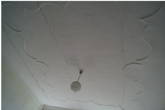
Abb. 3.1.24: Deckenstuck, Raum Nr. 16, Pfarrhaus Winden am See.
