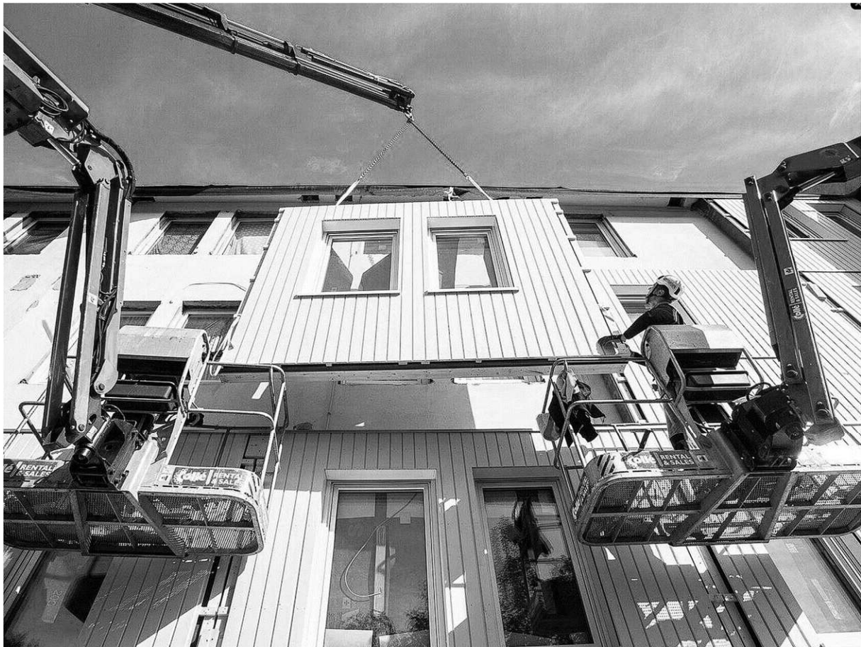
Abbildung 17 Montage der Fertigelemente auf der Baustelle
