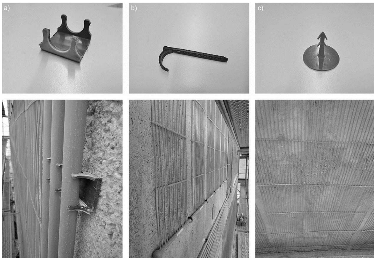
Abbildung 19 Montagebauteile für Wandtemperierung LEXU und LEXU II
