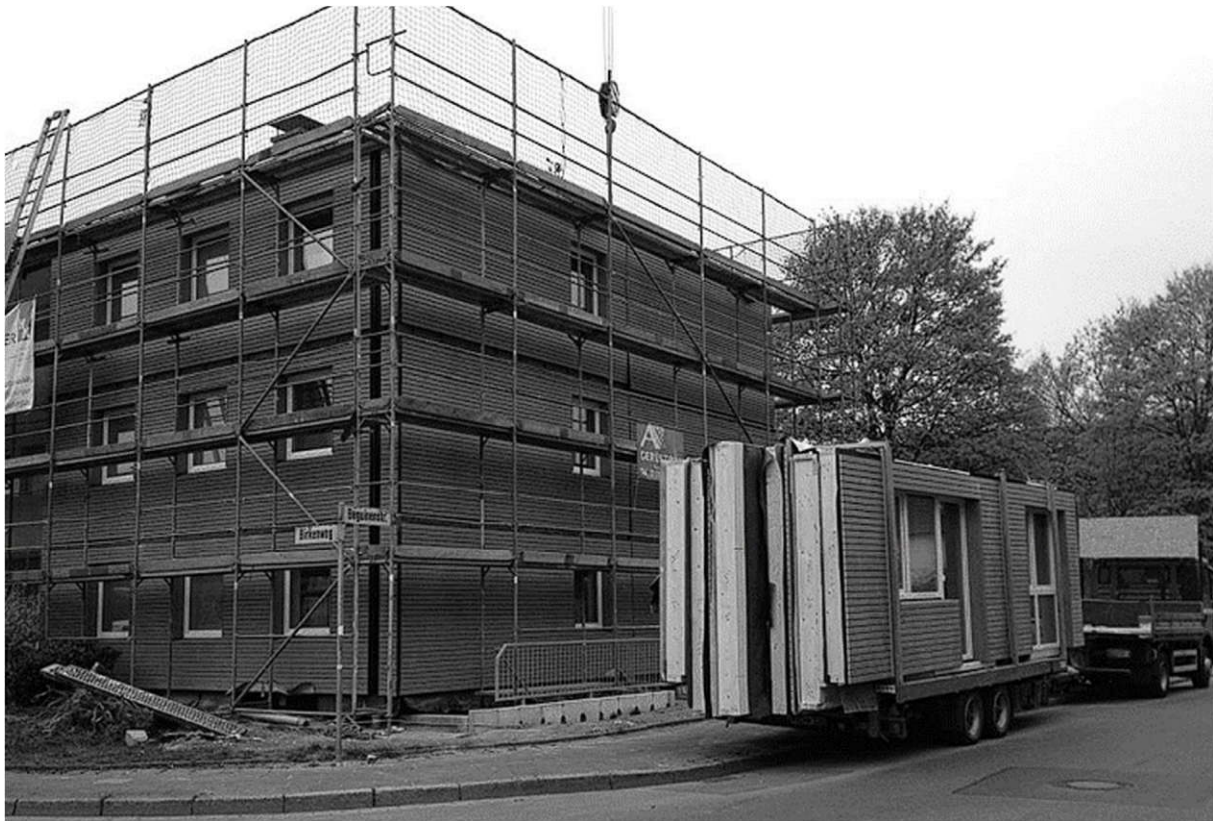
Abbildung 16 montierte Fertigelemente an Bestandswand
