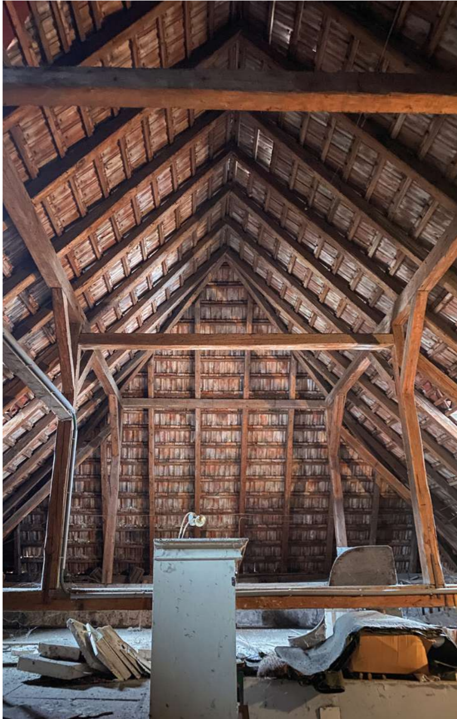
Abb.46: Dachgeschoss nicht genutzt (Foto: Stand Februar 2023)
