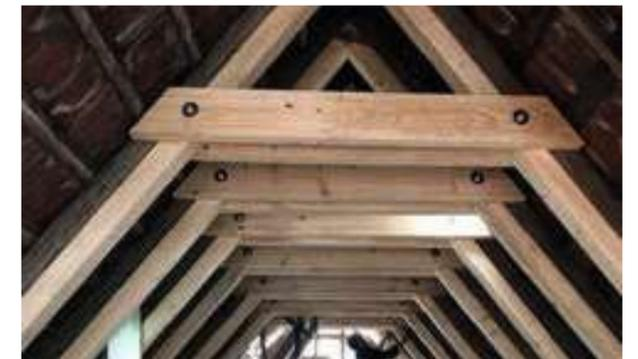
Abb.105 Verstärkter Dachstuhl
