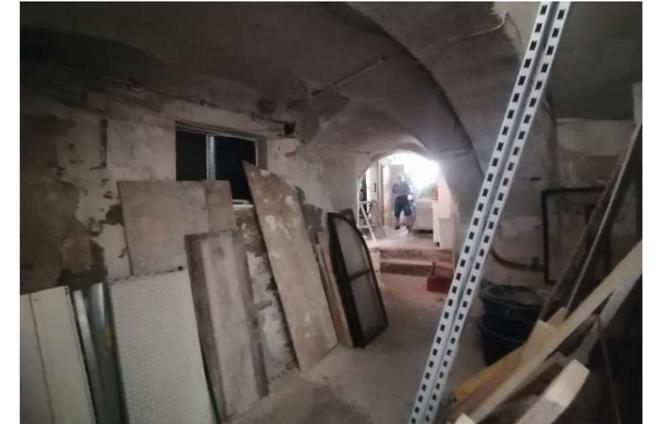
2 Der Keller ist ein Zubau zu dem ersten Bestandsgebäude, und die tragenden Bestandswände wurden mittels Bogenkonstruktionen gestützt.
