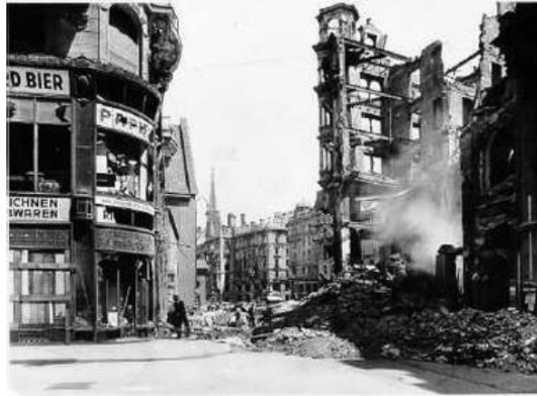
Abbildung 2: Zerstörung in Wien nach dem Zweiten Weltkrieg. Hier in der Inneren Stadt Nähe Neuer Markt; Quelle: [5]
