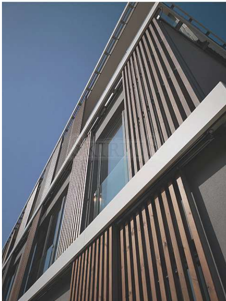
Abb.54: Die Schiebeläden aus Holz
