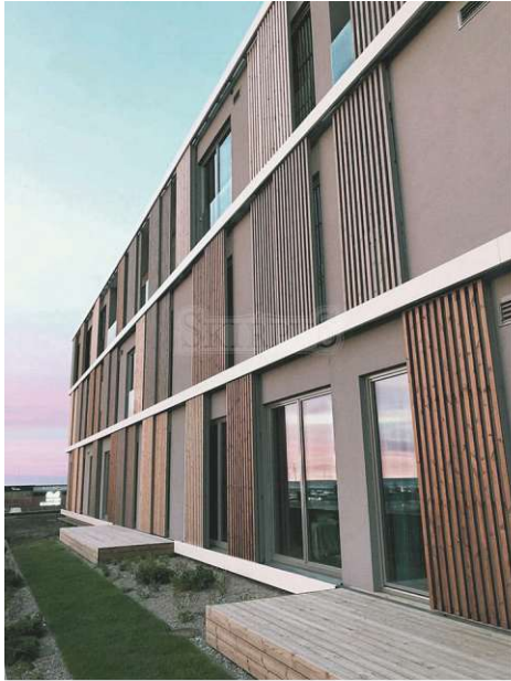
Abb.53: Die Schiebeläden aus Holz
