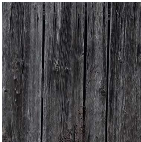
Altes, Verwittertes Holz
