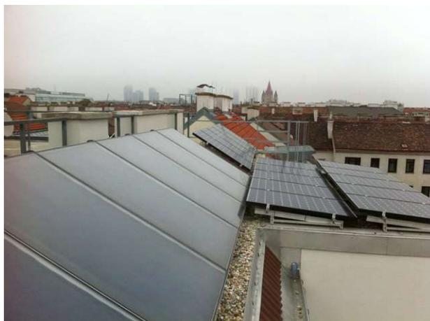
Abb. 112: Solar- und Photovoltaikpaneele auf der Dachfläche
