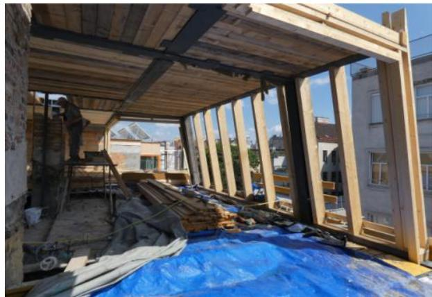
Abb. 70: Stahl- & Holzkonstruktion der Aufstockung ([www.proholz.at/fileadmin/proholz/media/proHolz\\_Projekte/Webinare/Webinare/2020/proHolz-Webinar-2-2020-Modul1-Zeiningger.pdf](http://www.proholz.at/fileadmin/proholz/media/proHolz_Projekte/Webinare/Webinare/2020/proHolz-Webinar-2-2020-Modul1-Zeiningger.pdf))
