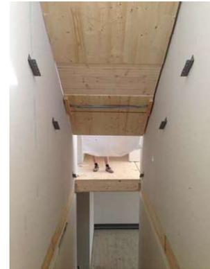
Abb. 95: Anschluss der Treppen mit Innenwand durch Profilaufleger (fach.vgq.ch/assets/Downloads-Event/10-Ho-MeyerReto-Rauti-Huus.pdf)
