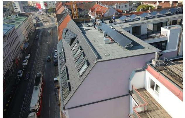
Abb. 63: Solarthermieanlage auf der Dachfläche ([www.hiberatlas.com/de/mariahilferstrasse--2-62.html#section3](http://www.hiberatlas.com/de/mariahilferstrasse--2-62.html#section3))
