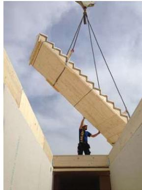
Abb. 94: Einheben der vorgefertigten Treppen (fach.vgq.ch/assets/Downloads-Event/10-Ho-MeyerReto-Rauti-Huus.pdf)
