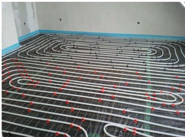
Abb. 110: Verlegung der Schläuche für Bauteilaktivierung
