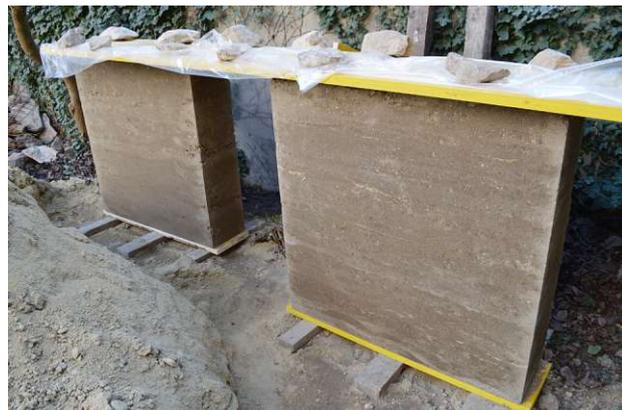
Abb. 30: Teile der aus dem Erdaushub hergestellten Lehmwände ([www.mia2.at/stadthaus-in-bau?lightbox=dataitem-kgnk3tut12](http://www.mia2.at/stadthaus-in-bau?lightbox=dataitem-kgnk3tut12))
