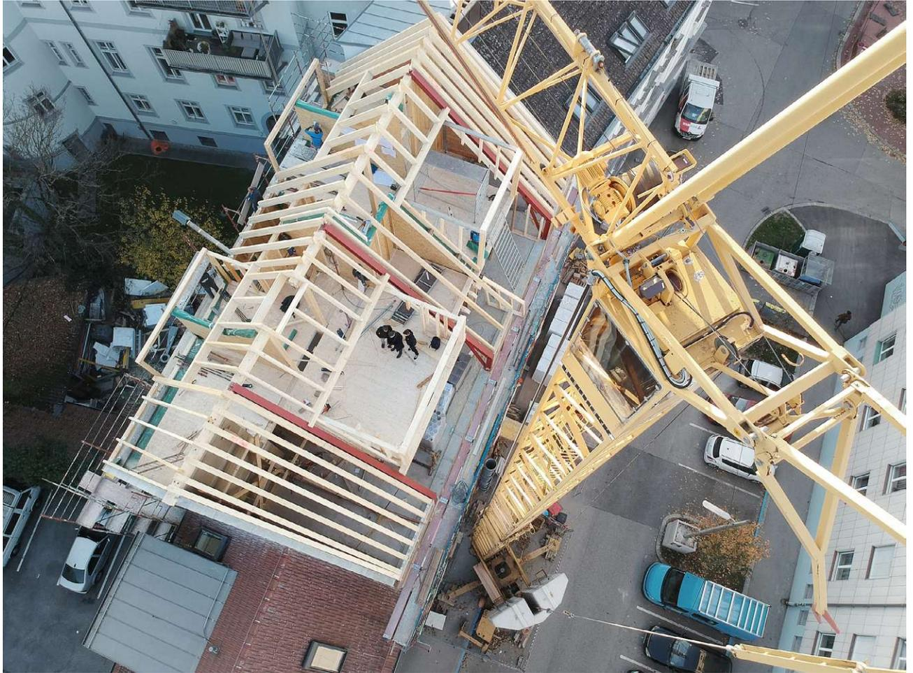
Abb. 29: Konstruktion des Dachgeschosses ([www.mia2.at/stadthaus-in-bau?lightbox=dataitem-kgk3tut17](http://www.mia2.at/stadthaus-in-bau?lightbox=dataitem-kgk3tut17))
