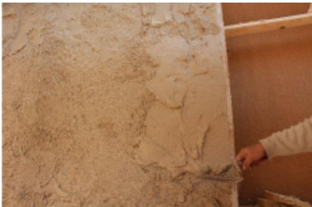
Abb. 51: Aufbringen des Aerogel-Dämmputzes (www.architekten.or.at/#subM\_87)
