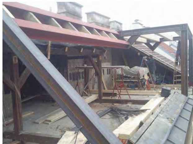
Abb. 104: Stahlrahmenkonstruktion des Dachstuhls (nachhaltigwirtschaften.at/resources/hdz\_pdf/endbericht\_1209\_ybbsstrasse\_dg.pdf)
