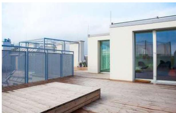
Abb. 102: Dachterrasse mit Thermoholzbelag ([passivehouse-database.org/#d\\_3762](https://passivehouse-database.org/#d_3762))
