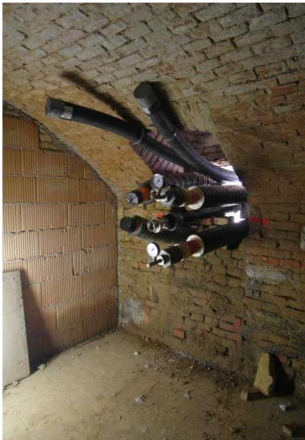
Abb. 81: Anschlüsse der Haustechnik (www.proholz.at/fileadmin/proholz/media/proHolz\_Projekte/Webinare/Webinare/2020/proHolz-Webinar-2-2020-Modull-Zeinger.pdf)
