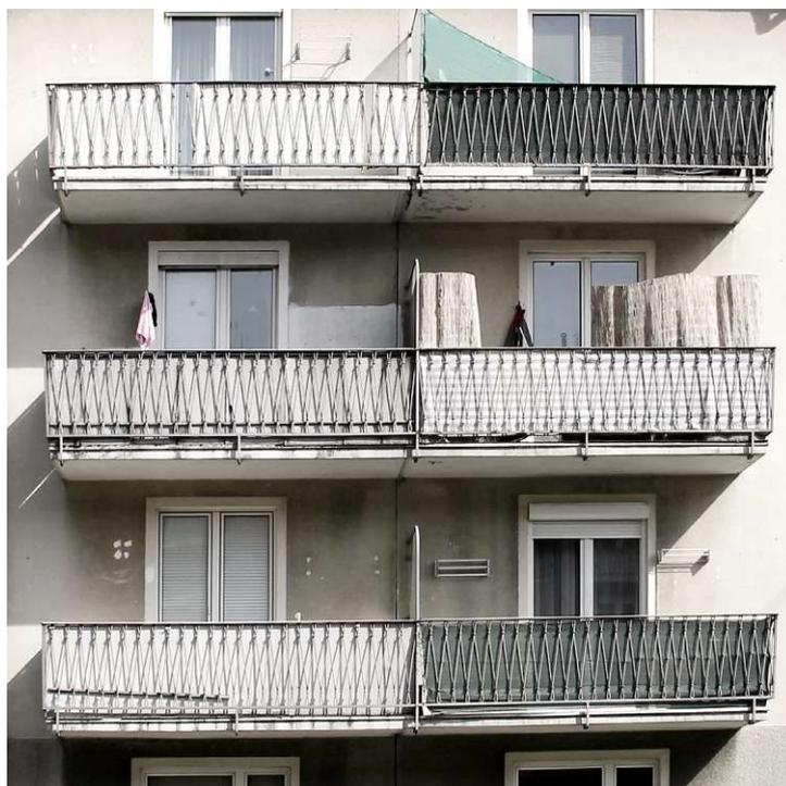
Abb. 31: Eisengeländer vor Wiederverwendung ([www.mia2.at/stadthaus-inbau?lightbox=dataitem-kgk3tuu16](http://www.mia2.at/stadthaus-inbau?lightbox=dataitem-kgk3tuu16))
