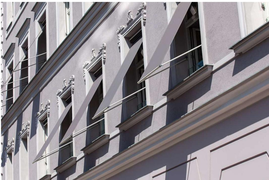
Abb. 42: Ausrollbarer Sonnenschutz in den Bestandsgeschosses ([klimaaktiv-gebaut.at/gebaut/objekte/all/sanierung-und-dg-ausbau-mariahilfer-strae-182/#gallery-3](http://klimaaktiv-gebaut.at/gebaut/objekte/all/sanierung-und-dg-ausbau-mariahilfer-strae-182/#gallery-3))
