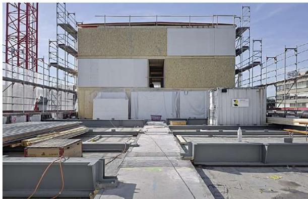
Abb. 90: Stahlträgerrost mit vorgefertigtem Holzbau im Hintergrund ([docplayer.org/50602734-Spillmann-echsl-architekten-ag-aufstockung-rautistrasse-11-13-staedtische-nachverdichtung-in-holzbauweise-die-herausforderungen.html](https://docplayer.org/50602734-Spillmann-echsl-architekten-ag-aufstockung-rautistrasse-11-13-staedtische-nachverdichtung-in-holzbauweise-die-herausforderungen.html))
