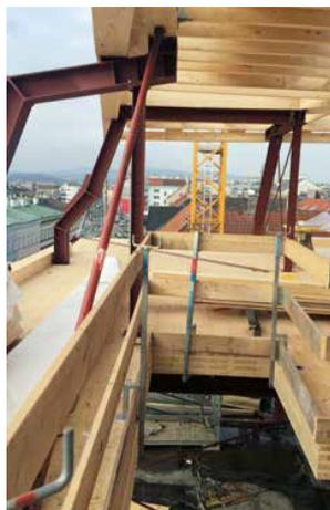
Abb. 57: Ausschnitt der Tragkonstruktion aus Stahl & Holz in der Aufstockung ([www.mikado-online.de/wp-content/uploads/projekt-finder/2021\\_05\\_Geschosswohnungsbau\\_Wien.pdf](http://www.mikado-online.de/wp-content/uploads/projekt-finder/2021_05_Geschosswohnungsbau_Wien.pdf))
