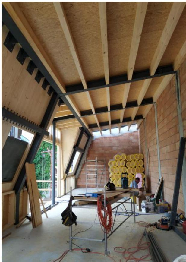
Abb. 71: Mischbaukonstruktion im Hofgebäude ([www.proholz.at/fileadmin/proholz/media/proHolz\\_Projekte/Webinare/Webinare/2020/proHolz-Webinar-2-2020-Modull-Zeinger.pdf](http://www.proholz.at/fileadmin/proholz/media/proHolz_Projekte/Webinare/Webinare/2020/proHolz-Webinar-2-2020-Modull-Zeinger.pdf))
