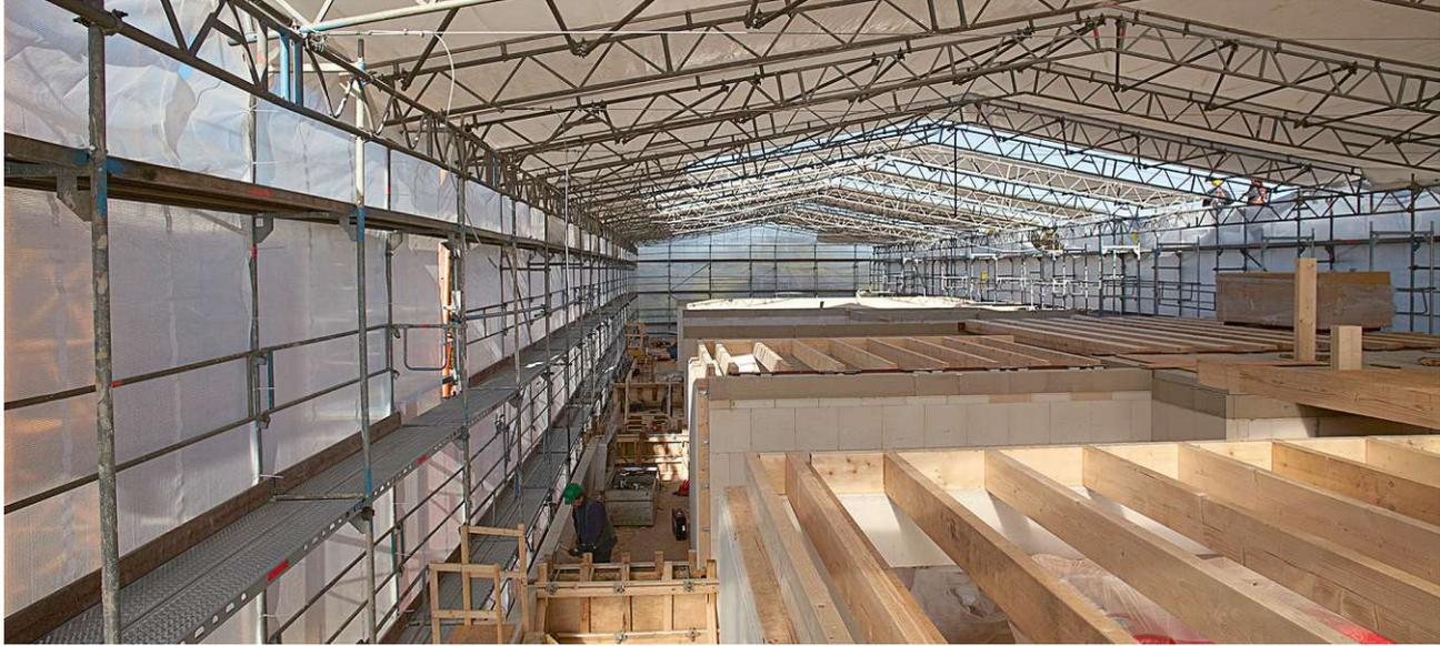
Abb. 9: Bauzustand einer Aufstockung aus Holz mit temporärem Notdach (Hermann Kaufmann, Stefan Krötsch, Stefan Winter: Atlas Mehrgeschossiger Holzbau, München 2021, S. 174)
