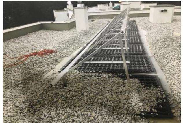
Abb. 78: Montagetechnik der Solarmodule durch flächiges Aufgewicht ([www.proholz.at/fileadmin/proholz/media/proHolz\\_Projekte/Webinare/Webinare/2020/proHolz-Webinar-2-2020-Modull-Zeinger.pdf](http://www.proholz.at/fileadmin/proholz/media/proHolz_Projekte/Webinare/Webinare/2020/proHolz-Webinar-2-2020-Modull-Zeinger.pdf))
