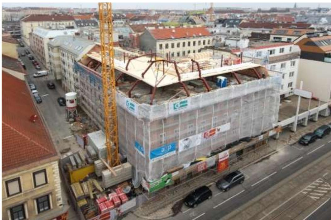
Abb. 53: Primäre Tragstruktur der Aufstockung ([www.holzbauaustria.at/architektur/2020/04/projekt-sanierung-mariahilfer-strasse-182.html](http://www.holzbauaustria.at/architektur/2020/04/projekt-sanierung-mariahilfer-strasse-182.html))
