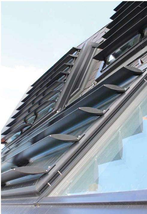
Abb. 44: Horizontale Sonnenschutzlamellen in den Aufstockungsgeschossen ([www.architekten.or.at/#subM\\_87](http://www.architekten.or.at/#subM_87))
