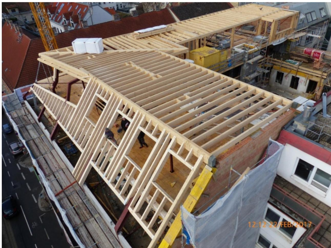
Abb. 59: Holzbalkenkonstruktion der Aufstockung ([www.holzbauaustria.at/architektur/2020/04/projekt-sanierung-mariahilfer-strasse-182.html](http://www.holzbauaustria.at/architektur/2020/04/projekt-sanierung-mariahilfer-strasse-182.html))
