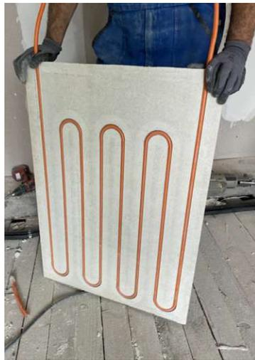
Abb. 80: Modul einer Kühldecke (www.proholz.at/fileadmin/proholz/media/proHolz\_Projekte/Webinare/Webinare/2020/proHolz-Webinar-2-2020-Modull-Zeinger.pdf)
