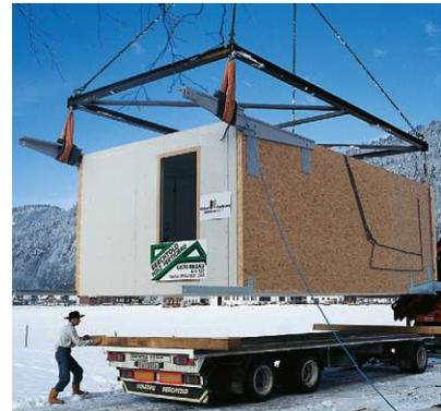
Abb. 6: Vorfertigung von linearen, flächigen und räumlichen Modulen (Hermann Kaufmann, Stefan Krötsch, Stefan Winter: Atlas Mehrgeschossiger Holzbau, München 2021, S. 163)
