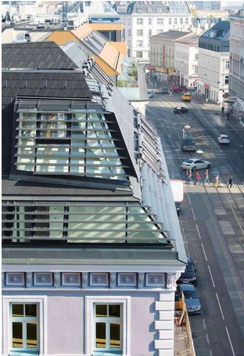
Abb. 43: Eckgaupe mit Sonnenschutzlamellen ([www.architekten.or.at/#subM\\_87](http://www.architekten.or.at/#subM_87))
