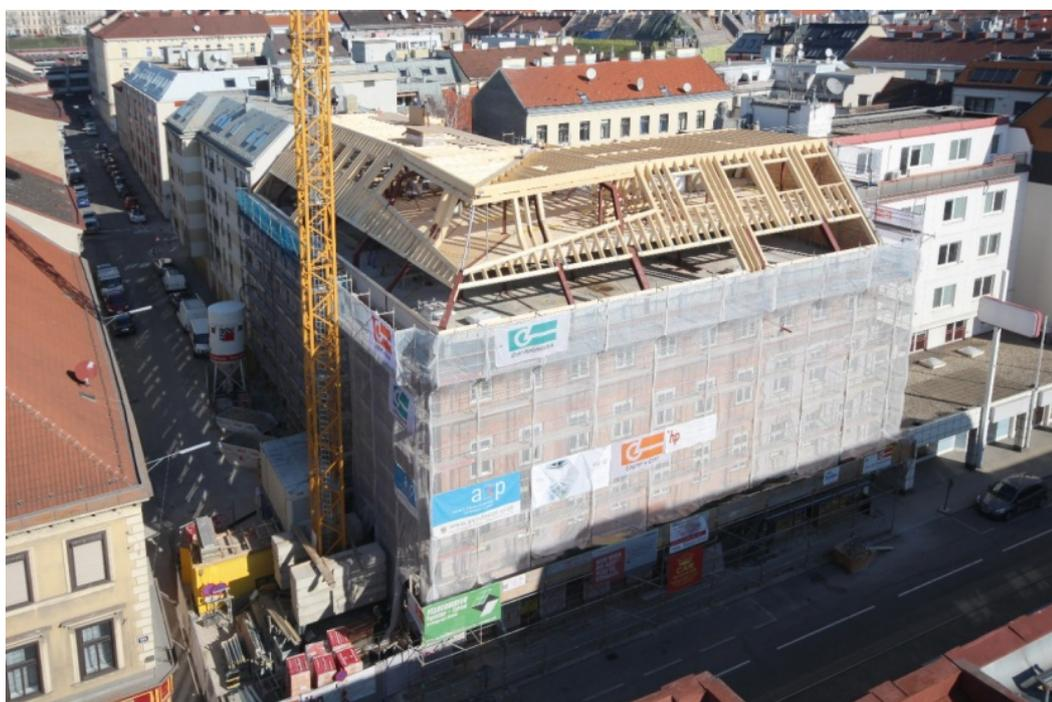
Abb. 54: Primäre & sekundäre Tragstruktur der Aufstockung ([www.holzbauaustria.at/architektur/2020/04/projekt-sanierung-mariahilfer-strasse-182.html](http://www.holzbauaustria.at/architektur/2020/04/projekt-sanierung-mariahilfer-strasse-182.html))
