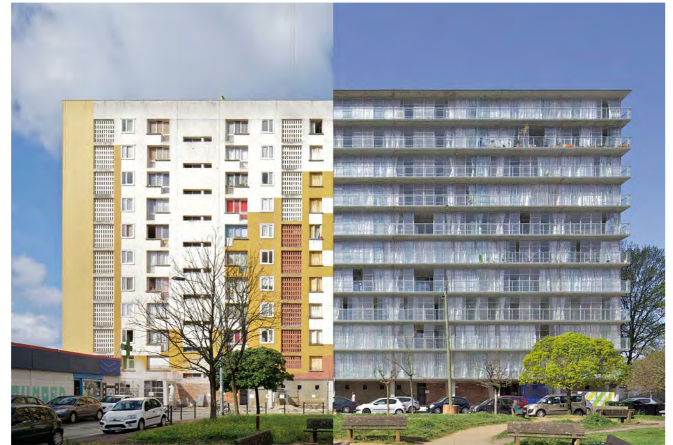
Abb.22 | Umgestaltung der Fassade
