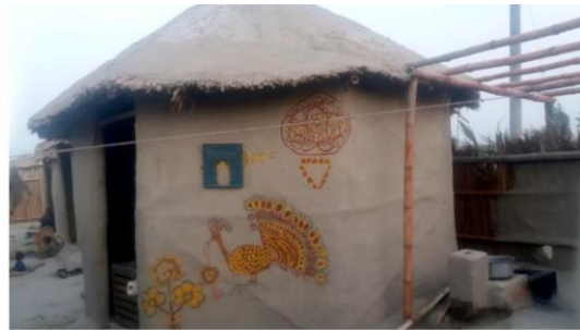
Abbildung 132: Zusätzliche Methode der Dachdeckung mit Matten (Quelle: Yasmeen Lari's Zero Carbon Channel, 2021, 17:02)
