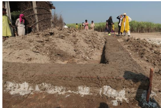
Abbildung 162: Herstellung des Streifenfundaments 1 (links) (Quelle: Eigene Aufnahme, 2022)
