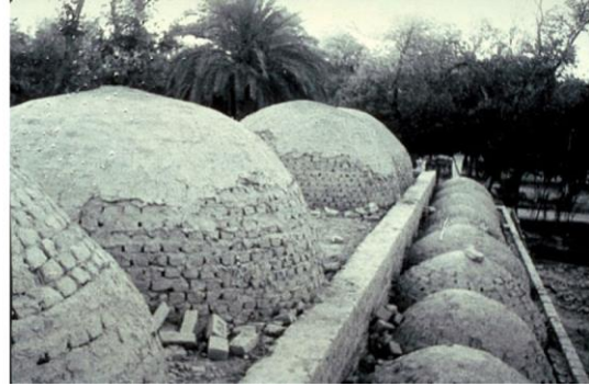
Abbildung 38: „Army Barracks“ während der Bauarbeiten (links) (Quelle: https://www.archnet.org/sites/347 ) Abbildung 39: Kuppeln aus Lehmziegel (rechts) (Quelle: https://www.archnet.org/sites/347 )
