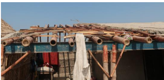
Abbildung 118: Hybride Dachkonstruktion mit traditionellen Materialien sowie Stahl, Bambus und Plastikfolie (links) (Quelle: Eigene Aufnahme, 2022) Abbildung 119: Hybride Dachkonstruktion mit traditionellen Materialien und Bambus (rechts) (Quelle: Eigene Aufnahme, 2022)
