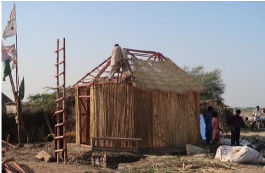
Abbildung 170: Herstellung der Dachdeckung 1 (links) (Quelle: Eigene Aufnahme, 2022)
