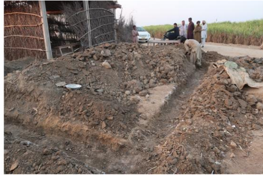
Abbildung 161: Aushub des Streifenfundaments (rechts) (Quelle: Eigene Aufnahme, 2022)
