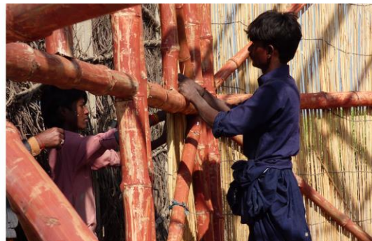
Abbildung 172: Verbindung der Bambuselemente mit Nägeln (links) (Quelle: Wagner, 2022)
