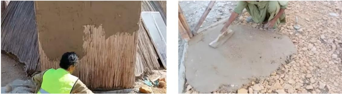
Abbildung 134: Aufbringung von Lehmalkputz (Quelle: Yasmeen Lari's Zero Carbon Channel, 2021, 19:29)
