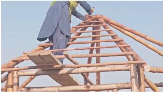
Abbildung 130: Herstellung der Unterkonstruktion für die Dachdeckung (links) (Quelle: Yasmeen Lari's Zero Carbon Channel, 2021, 15:22)
