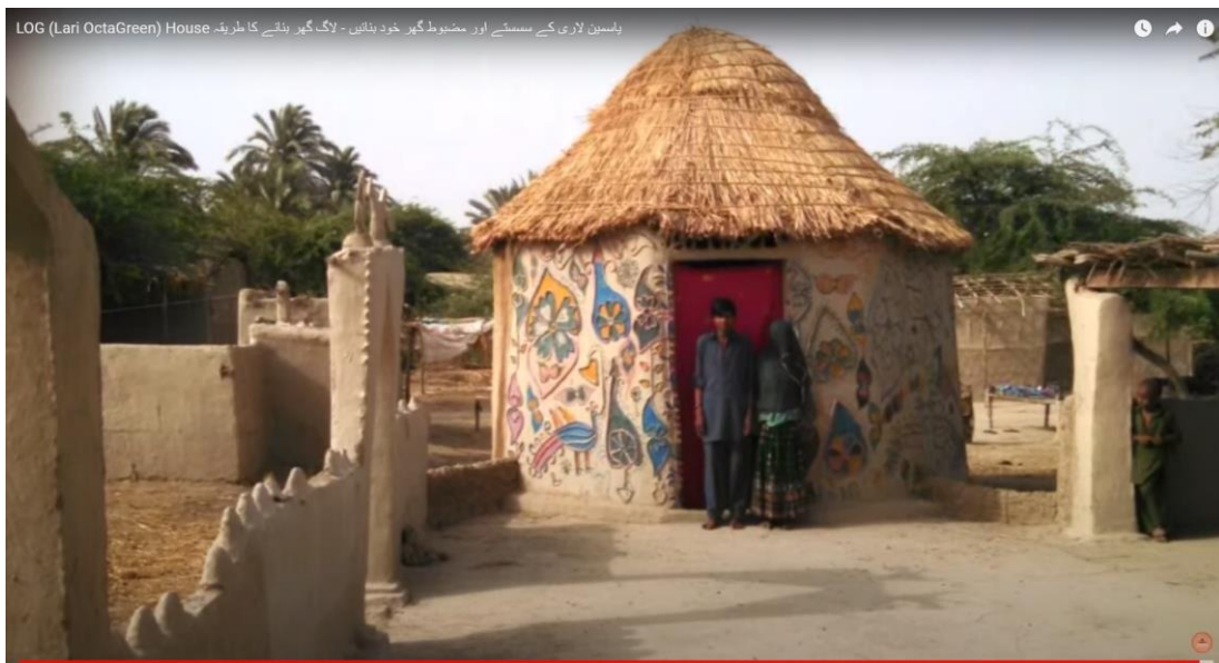
Abbildung 136: Verziertes LOG-Gebäude (Quelle: Yasmeen Lari's Zero Carbon Channel, 2021, 22:38)
