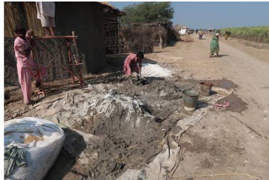
Abbildung 176: Herstellung des Kalklehmputzes 1 (links) (Quelle: Eigene Aufnahme, 2022) Abbildung 177: Herstellung des Kalklehmputzes 2 (rechts) (Quelle: Eigene Aufnahme, 2022)
