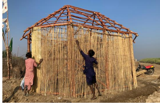
Abbildung 166: Errichtung der Bambuselemente (links) (Quelle: Eigene Aufnahme, 2022)
