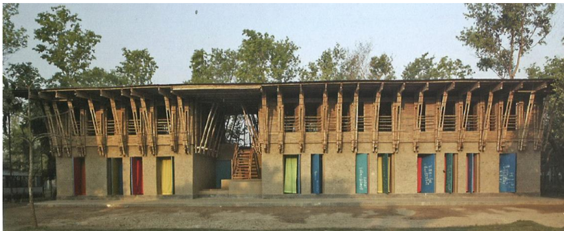
Abbildung 66: Schulgebäude in Rudrapur (Quelle: Minke, 2009, S. 195)
