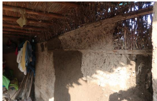
Abbildung 112: Unterkonstruktion für Lehmwurf (links) (Quelle: Eigene Aufnahme, 2022)
