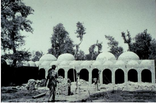
Abbildung 38: „Army Barracks“ während der Bauarbeiten (links) (Quelle: https://www.archnet.org/sites/347 ) Abbildung 39: Kuppeln aus Lehmziegel (rechts) (Quelle: https://www.archnet.org/sites/347 )
