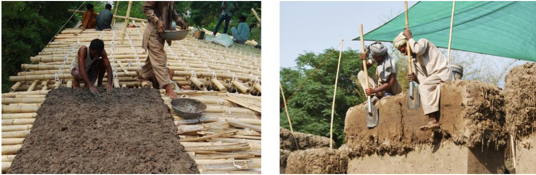
Abbildung 74: Ausführung der Deckenkonstruktion (links) (Quelle: Roswag-Ziegert, 2014, https://www.holcimfoundation.org/projects/locally-manufactured-cob-and-bamboo-school-building-jar-maulwi ) Abbildung 75: Herstellung der Wände aus Wellerlehm (rechts) (Quelle: Roswag-Ziegert, 2014, https://www.holcimfoundation.org/projects/locally-manufactured-cob-and-bamboo-school-building-jar-maulwi )
