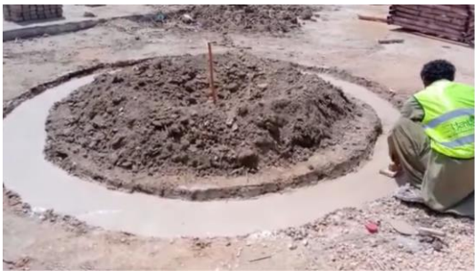
Abbildung 122: Herstellung des Fundaments (links) (Quelle: Yasmeen Lari's Zero Carbon Channel, 2021, 07:02)
