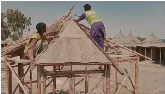
Abbildung 132: Zusätzliche Methode der Dachdeckung mit Matten (Quelle: Yasmeen Lari's Zero Carbon Channel, 2021, 17:02)
