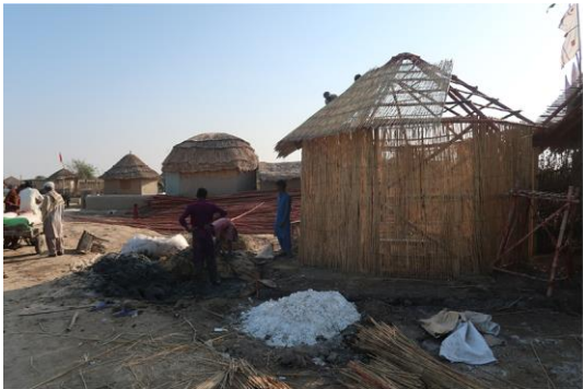
Abbildung 176: Herstellung des Kalklehmputzes 1 (links) (Quelle: Eigene Aufnahme, 2022) Abbildung 177: Herstellung des Kalklehmputzes 2 (rechts) (Quelle: Eigene Aufnahme, 2022)
