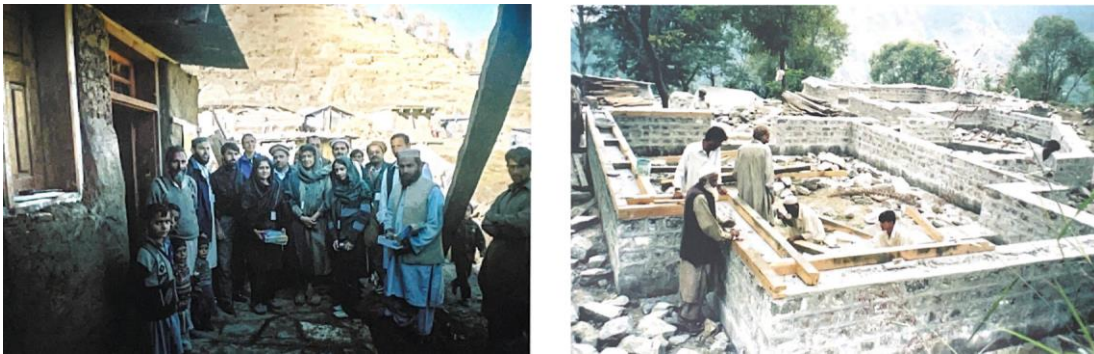
Abbildung 49: Wiederaufbau in Swat (Quelle: Fitz/Krasny/Mazhar, 2023, S. 100)
