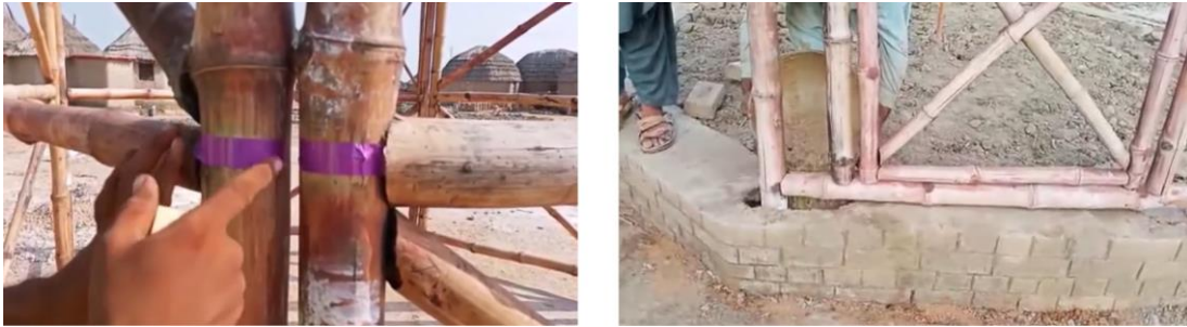
Abbildung 126: Markierung der Paneele (links) (Quelle: Yasmeen Lari's Zero Carbon Channel, 2021, 11:00)
