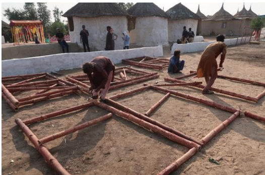
Abbildung 168: Herstellung von Bambusmodulen 1 (links) (Quelle: Eigene Aufnahme, 2022)
