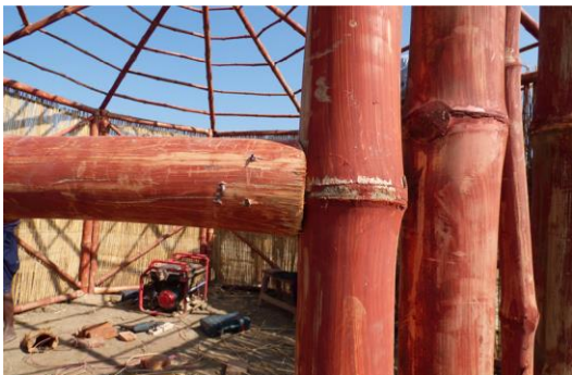
Abbildung 172: Verbindung der Bambuselemente mit Nägeln (links) (Quelle: Wagner, 2022)
