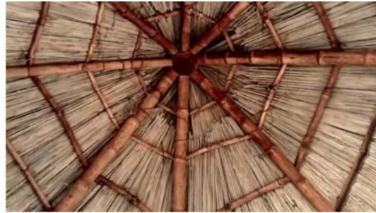
Abbildung 130: Herstellung der Unterkonstruktion für die Dachdeckung (links) (Quelle: Yasmeen Lari's Zero Carbon Channel, 2021, 15:22)
