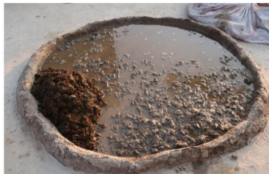
Abbildung 114: Vorbereitung des Kuhdunges für Bautätigkeiten 1 (links) (Quelle: Eigene Aufnahme, 2022)
