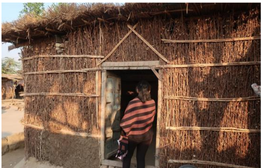
Abbildung 112: Unterkonstruktion für Lehmwurf (links) (Quelle: Eigene Aufnahme, 2022)
