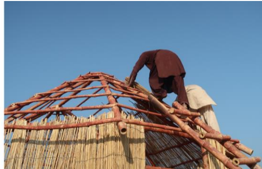
Abbildung 170: Herstellung der Dachdeckung 1 (links) (Quelle: Eigene Aufnahme, 2022)
