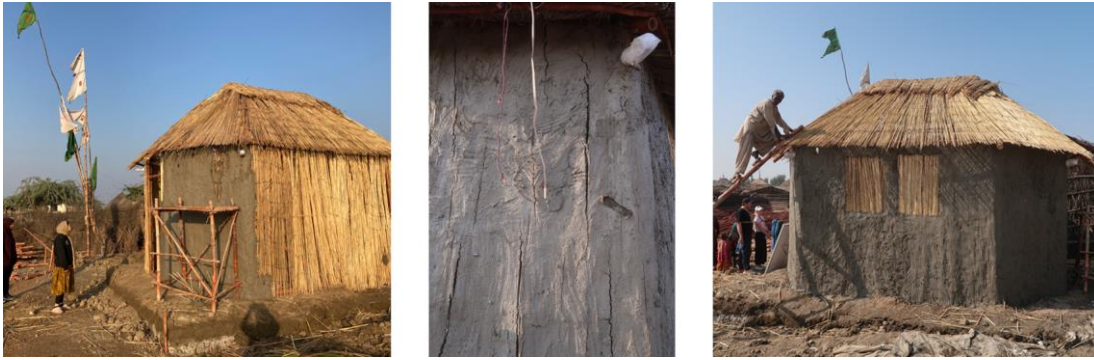
Abbildung 178: Auftragen des Kalklehmputzes (links) (Quelle: Lechner, 2022)
