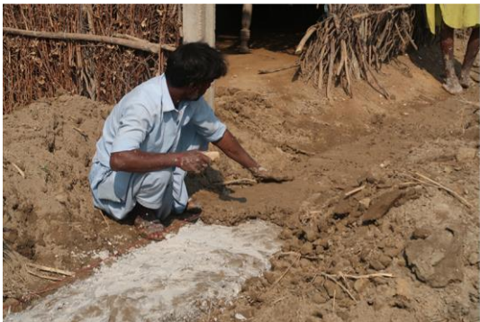
Abbildung 162: Herstellung des Streifenfundaments 1 (links) (Quelle: Eigene Aufnahme, 2022)
