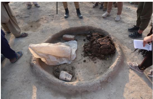
Abbildung 114: Vorbereitung des Kuhdunges für Bautätigkeiten 1 (links) (Quelle: Eigene Aufnahme, 2022)
