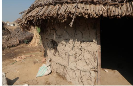
Abbildung 108: Wellerlehmbauweise bei einem rechteckigen Gebäude (links) (Quelle: Eigene Aufnahme, 2022)
