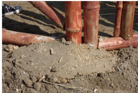
Abbildung 163: Herstellung des Streifenfundaments 2 (rechts) (Quelle: Eigene Aufnahme, 2022)
