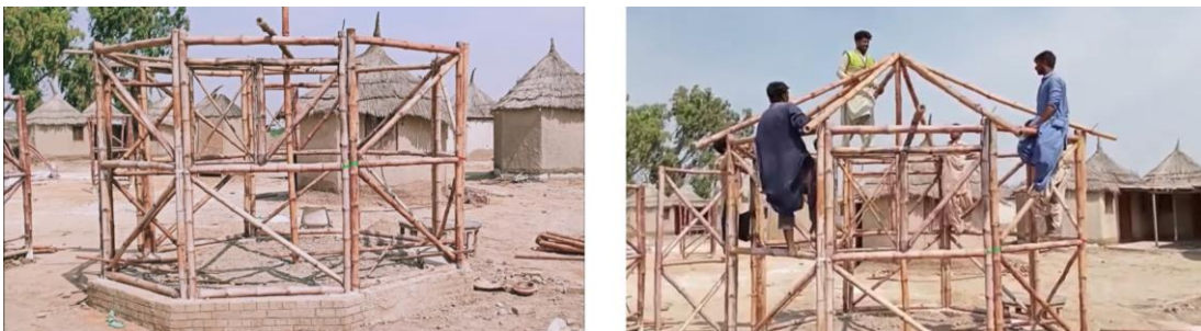
Abbildung 128: Herstellung der Wandpaneelkonstruktion (links) (Quelle: Yasmeen Lari's Zero Carbon Channel, 2021, 13:03)
