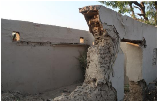
Abbildung 110: Sichtbarkeit der Lehmalkonstruktion 1 (links) (Quelle: Eigene Aufnahme, 2022)
