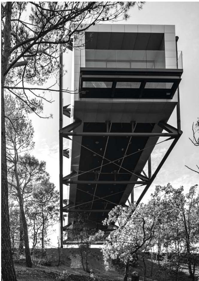
Auskragungen, bei denen Gebäudeteile über den Boden hinausragen, können durch die Verwendung von Zugseilen und Fachwerkkonstruktionen umgesetzt werden. Diese technischen Lösungen ermöglichen es, die Auskragungen stabil zu halten und gleichzeitig ästhetische Akzente zu setzen.
