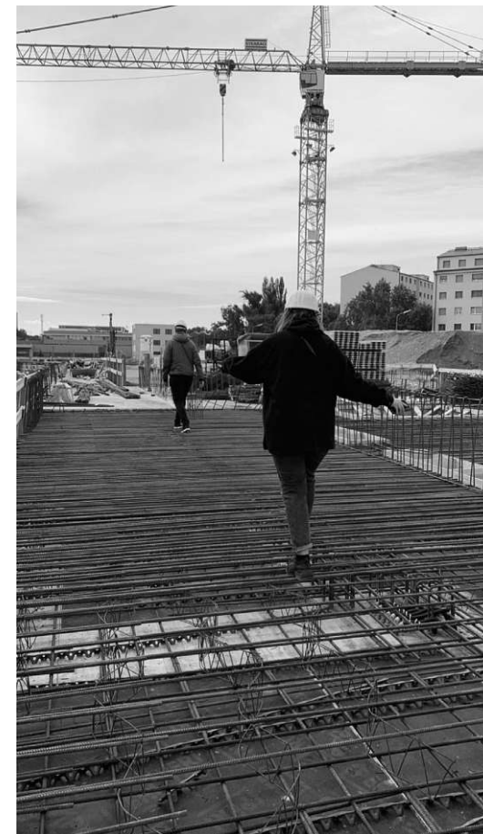
Abb. 03 Planungsteam „POS architecture“ auf der Baustelle © pos architecture
