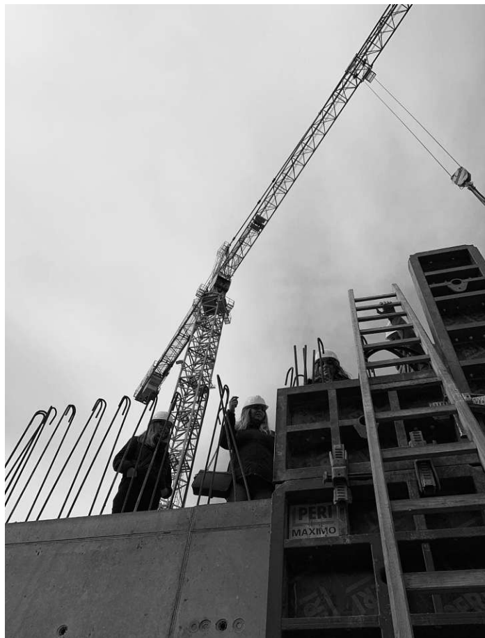
Abb. 02 Planungsteam „POS architecture“ auf der Baustelle © pos architecture
