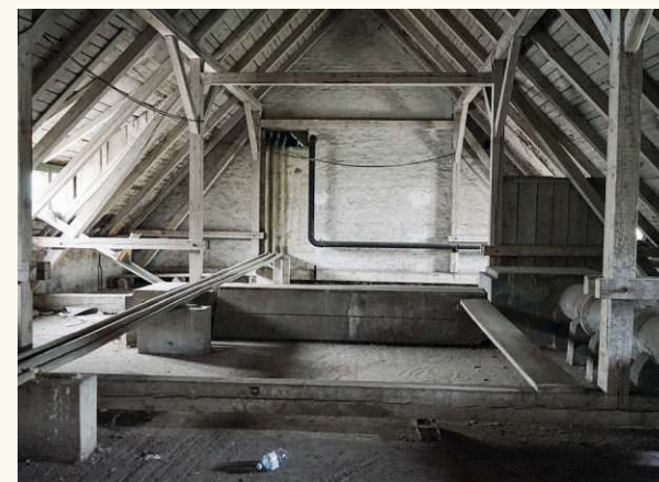
Abb. 184 | Zustand des Dachstuhls, 2023
