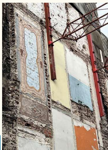
Abb. 20 | teilweiser Abriss eines Wohngebäudes in Blankenberge
