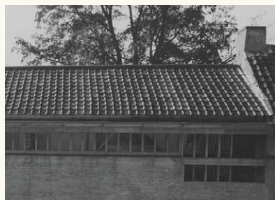
Abb. 52 | House Van Hee Straßenansicht mit schmalem Fensterband im OG
