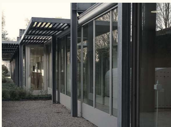
Abb. 35 | Weiße Stahlstruktur des Office and Apartement Baillieu, 2003-2010
