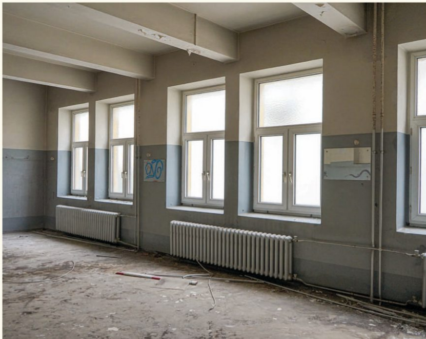
Bestand: ehem. Umkleide
