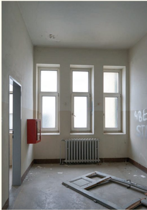
Abb. 180 | Gangbereich im Obergeschoss
