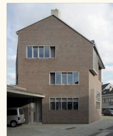
Abb. 37 | Westfassade des House and Practice Van Aelten - Oosterlinck, 2005-2011
