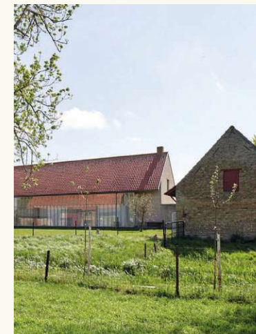
Abb. 95 | Bestehendes und Hinzugefügtes am House A-B
