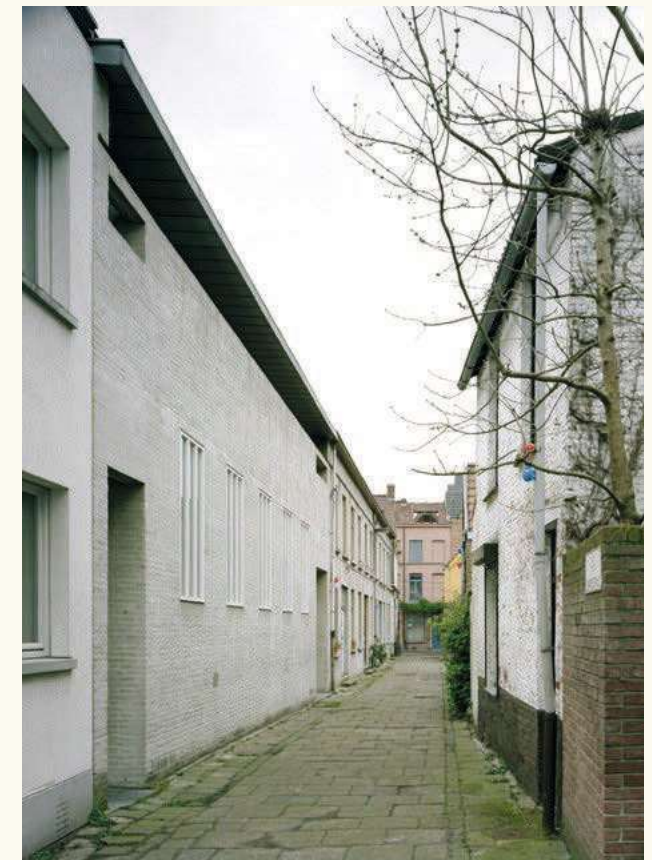
Abb. 86 | House Van Hee im Gefüge der Häuserfront
