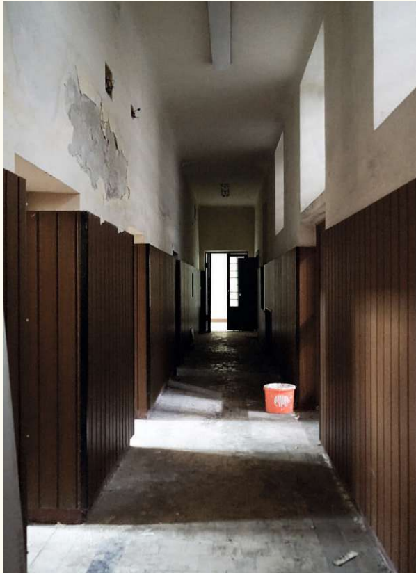
Abb. 173 | Flur im Erdgeschoss
