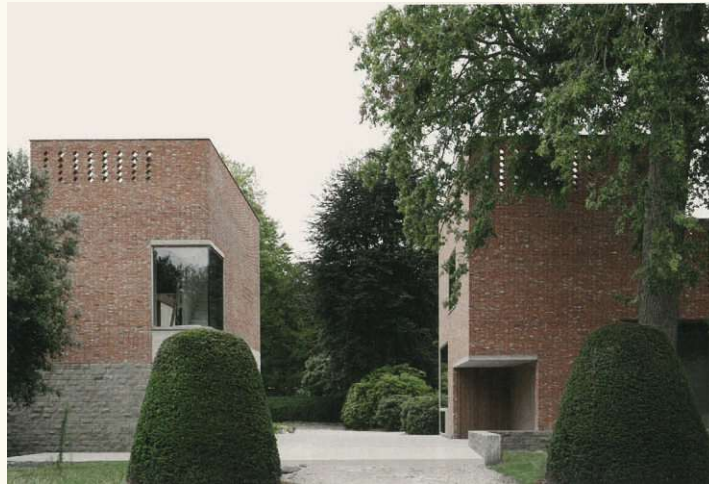
Abb. 38 | Straßenseite des House V-D, Gent, 2007-2019
