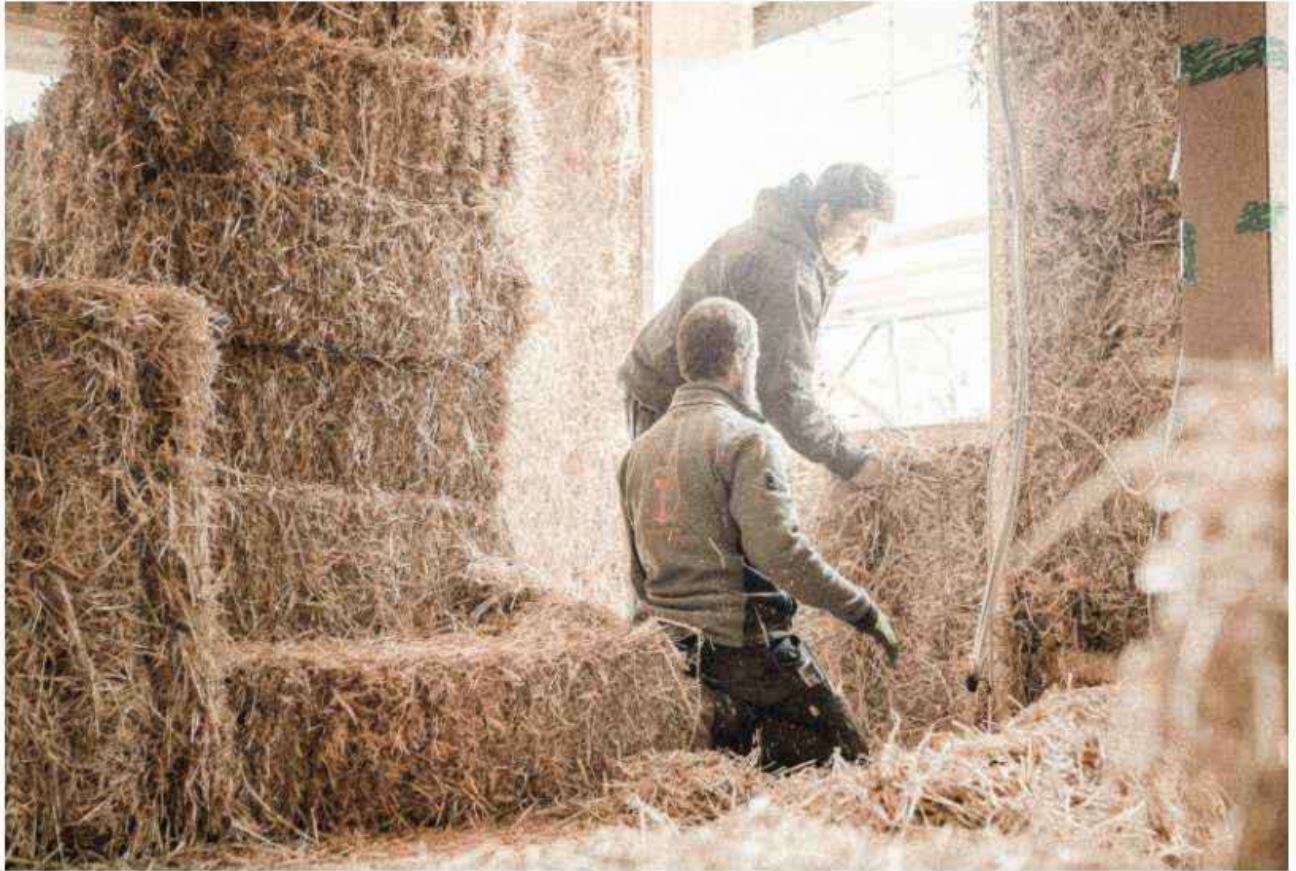
17 Einbringung Strohballendämmung
