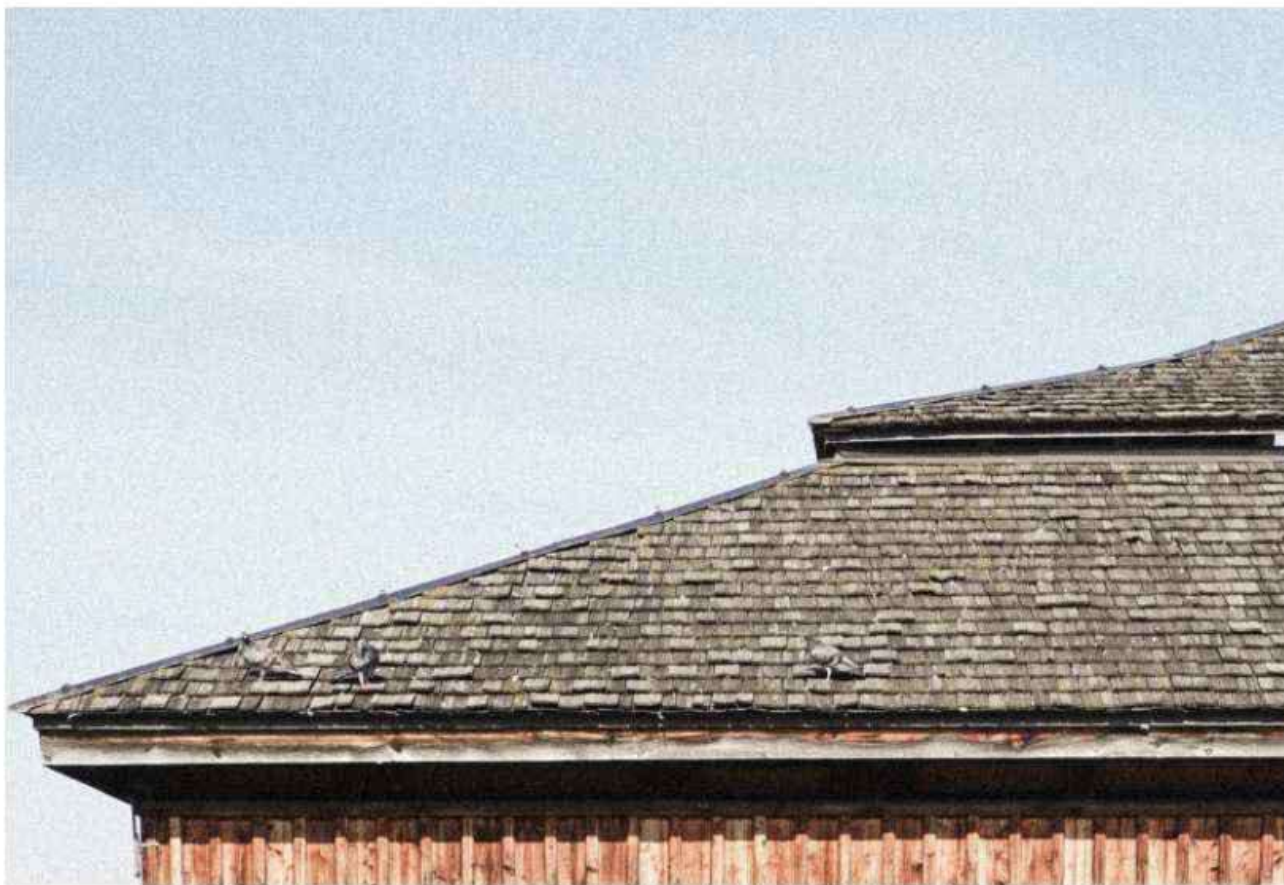
108 Militärbad Bregenz Dach
