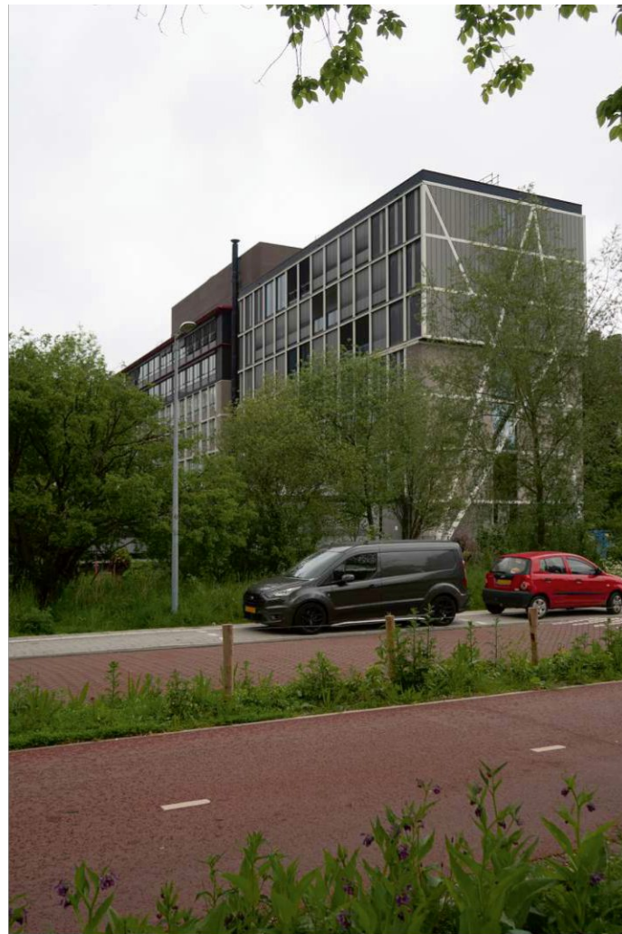
Abbildung 4.3: Das W&N Gebäude Abschnitt A und B (saniert), Eigene Fotografie
