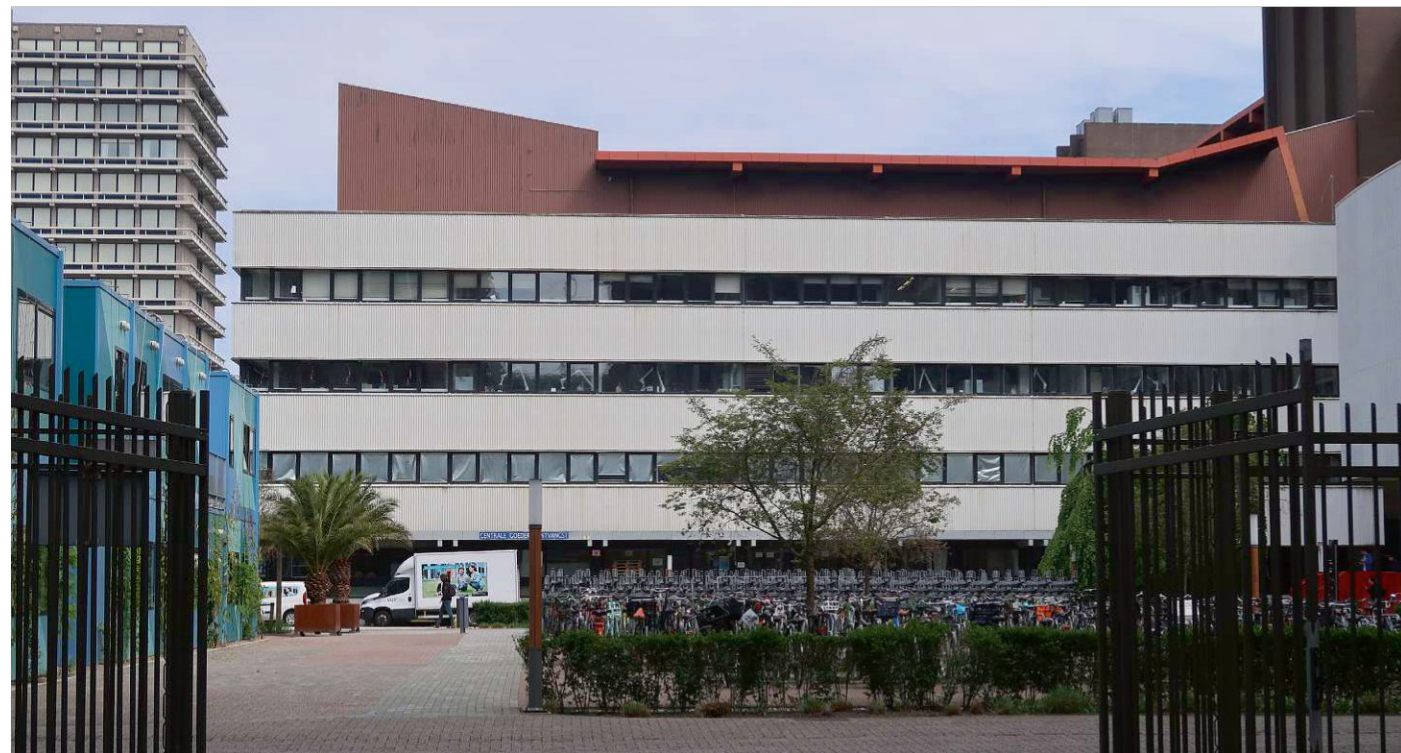
Abbildung 4.4: Das W&N Gebäude Abschnitt J des Mittelbaukörpers (Ansicht aus dem Universitätshof), Eigene Fotografie
