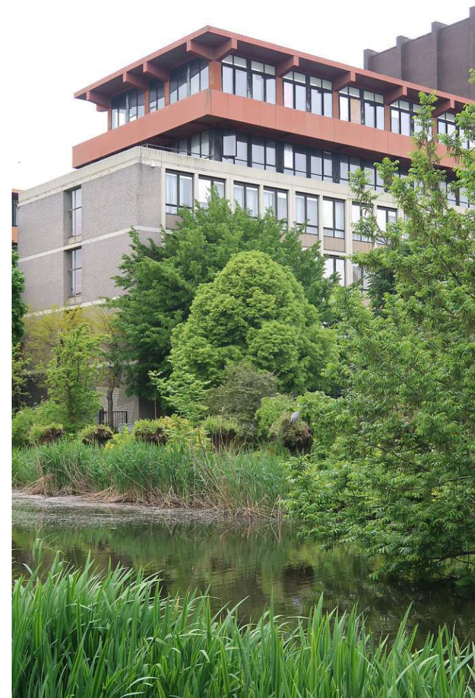
Abbildung 2.13: W&N Gebäude der Freien Universität Amsterdam (Südseite), Eigene Fotografie
