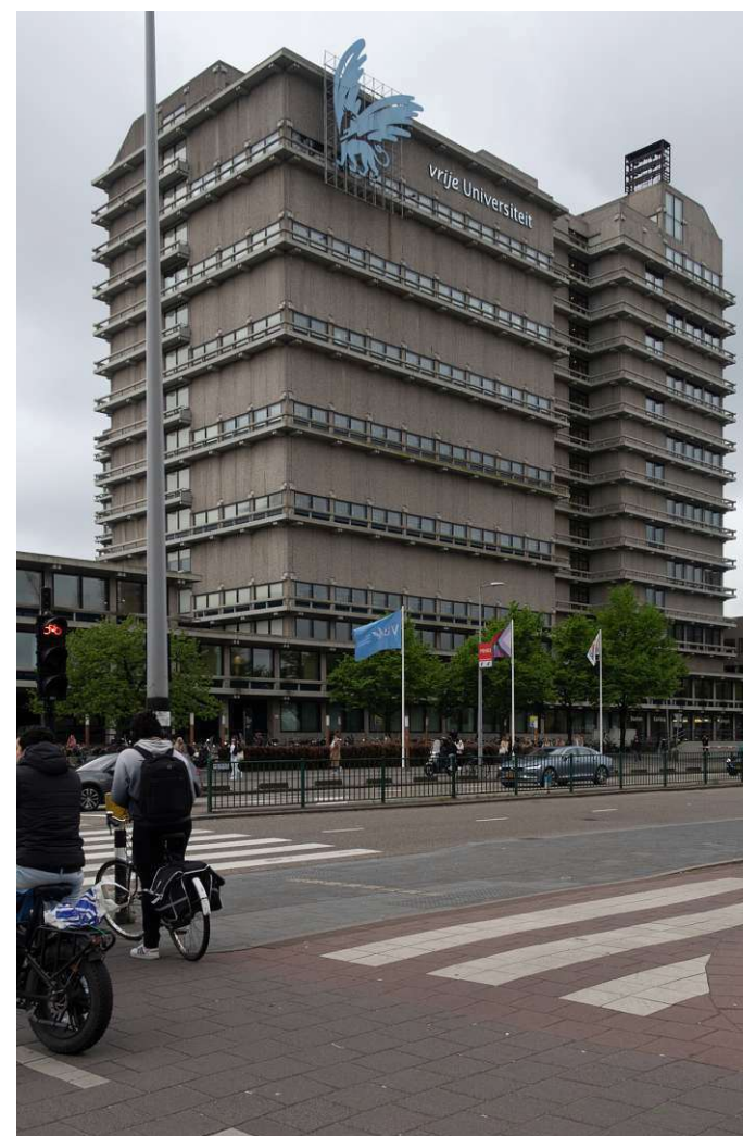
Abbildung 2.14: Hauptgebäudes der Freien Universität Amsterdam (Nordseite), Eigene Abbildung
