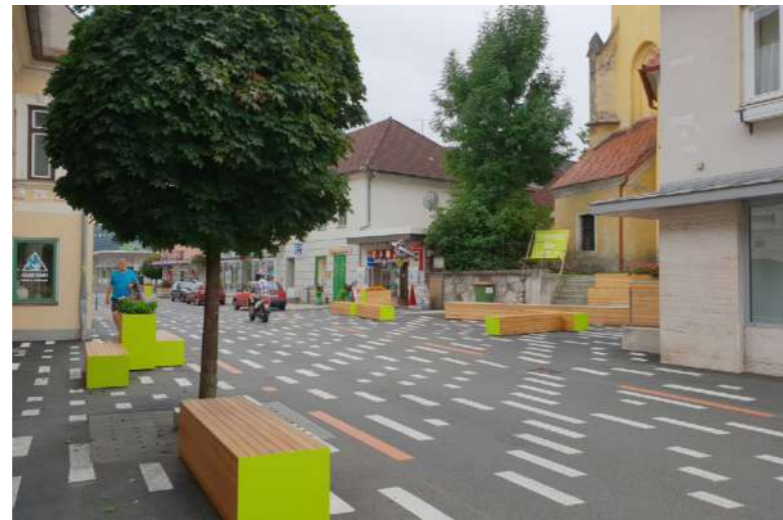
Abb. 65: Begegnungszone Trofaia, Platzgestaltung vor der Kirche, Foto: Walk-space.at
