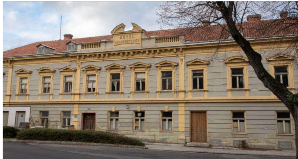
Abb.28: ehemaliges Sommerfrische Hotel 'Rabensteiner' in Pottschach, Google Maps
