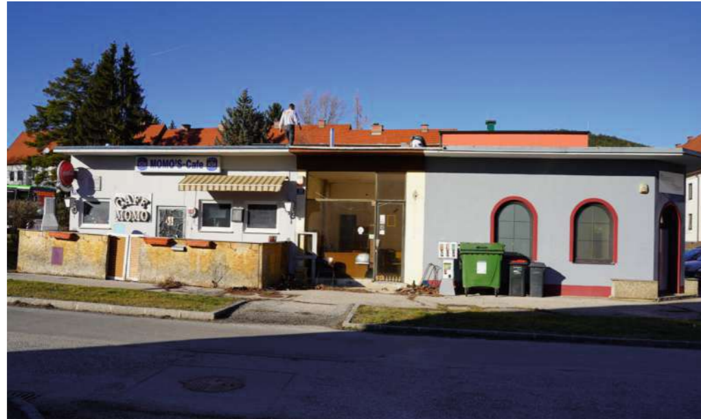
Abb.36: Leerstand in der ehemaligen Ladenzeile, Foto: einszueins Architektur, Stand: 2022
