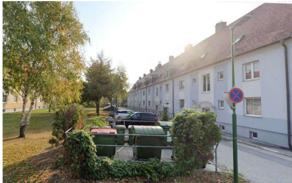
Abb.50: Sanierte Wohnzeile in der ehemaligen Arbeiter:innen-siedlung in Neu-Guntramsdorf, Foto: Google Maps
