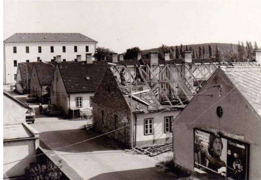
Abb.21: Abbruch der Wohnhäuser Gimplinsel Ternitz 1971, Museumsstraße Ternitz
