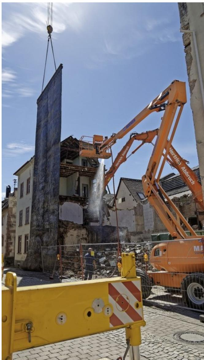
**Abb. 4.6:** Einsatz eines Abbruchvorhangs bei Abbrucharbeiten außerhalb geschlossener Räume
