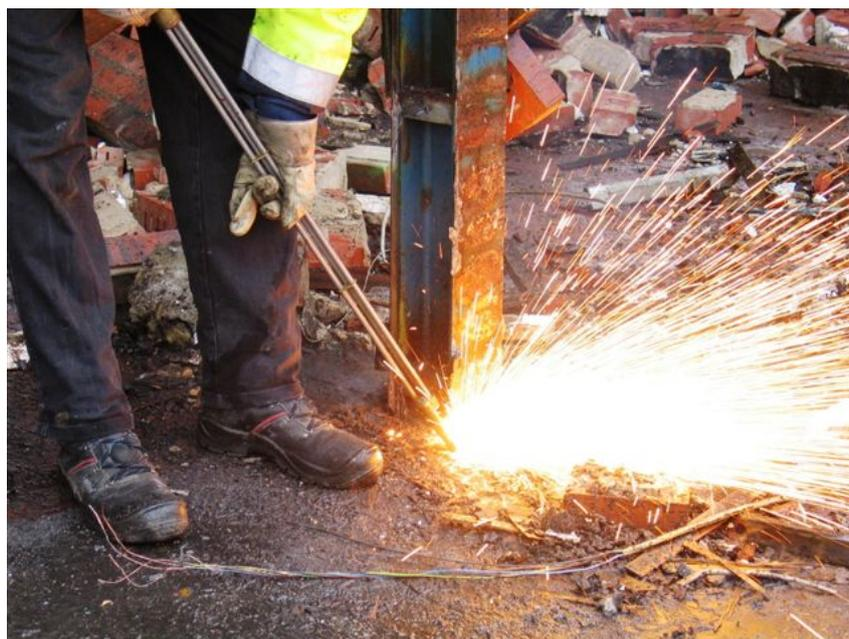
**Abb. 3.7:** Thermisches Trennen mittels Schneidbrenner (Quelle: Helge [25])
