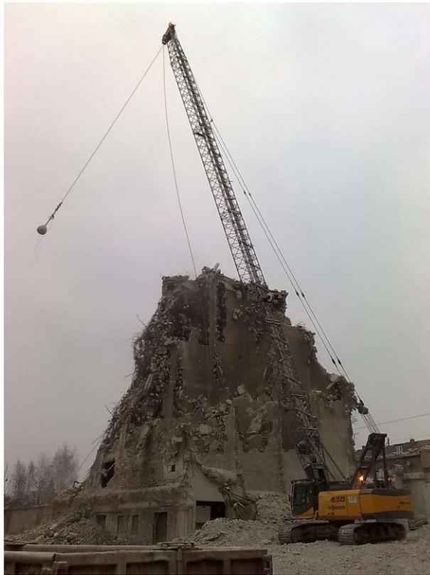
**Abb. 3.6:** Abbruch durch Einschlagen unter Verwendung eines Seilbaggers (Quelle: Kühn [29])
