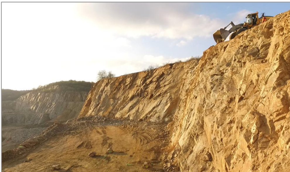
Abb.3.1: Versuchsböschung Limberg (Foto E. Fleris, Institut für Geotechnik, Forschungsbereich für Ingenieurgeologie der TU Wien)
