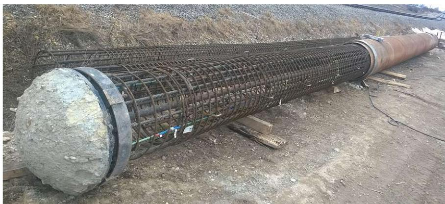
**Abb. 5.5:** Bewehrungskorb eines Miozänpfahls mit Doppelwandrohr und Druckmessdose (Foto: ARGE – FPUH)
