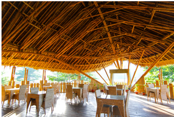
Abb. 74 große Spannweiten für die Veranstaltungsfläche
