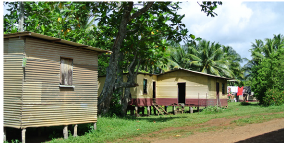
Abb. 38-42 Häuser aus Betonziegeln, Wellblech, Holz
