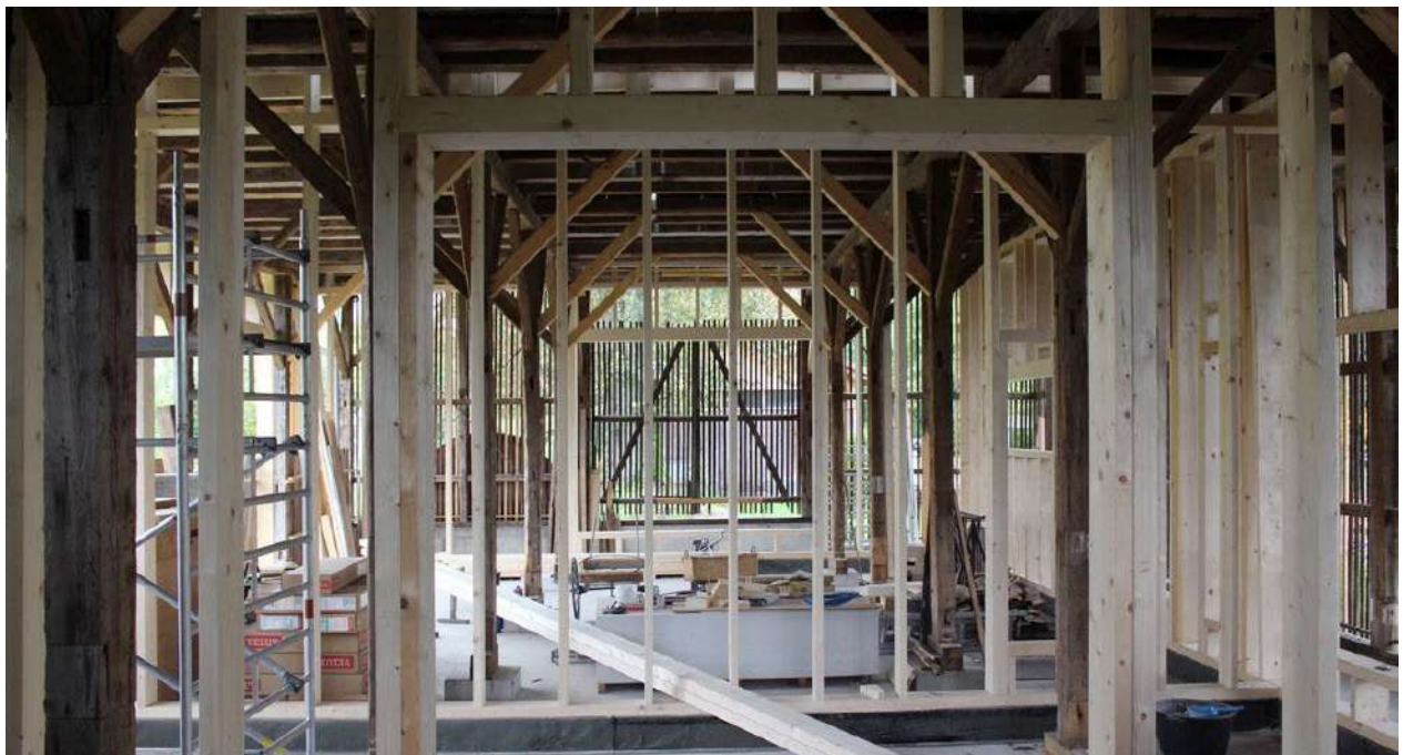
Abbildung 52: Holzkonstruktion im Wiederaufbau Torfremise 108
