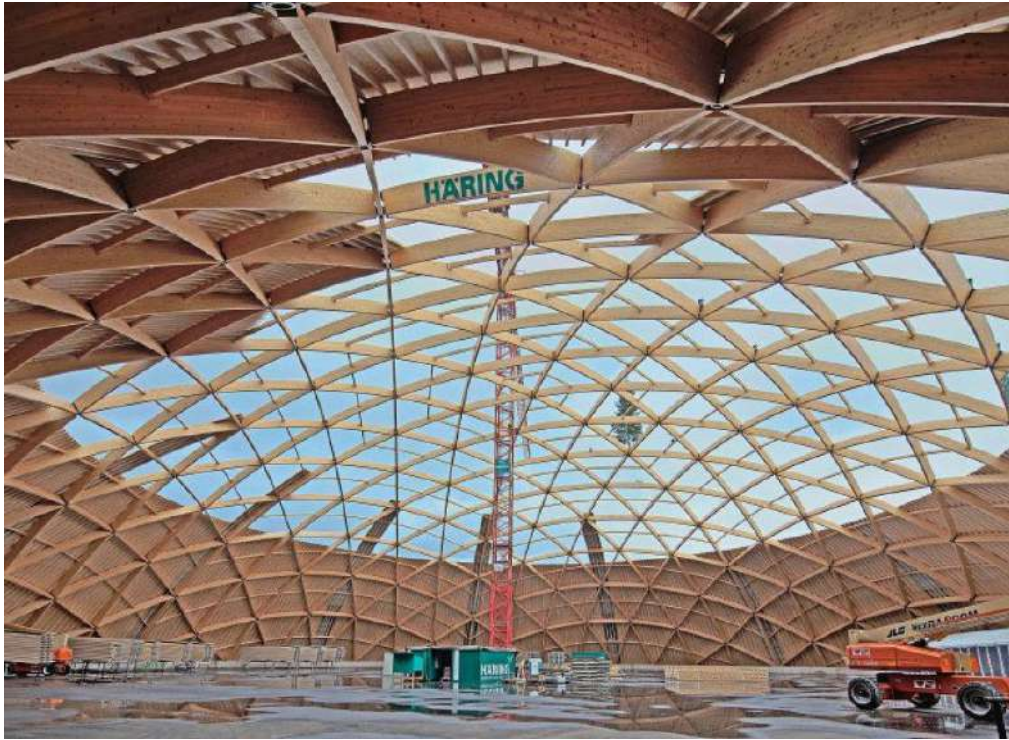
Abbildung 24: Tragwerk der Rheinsalinen 78
