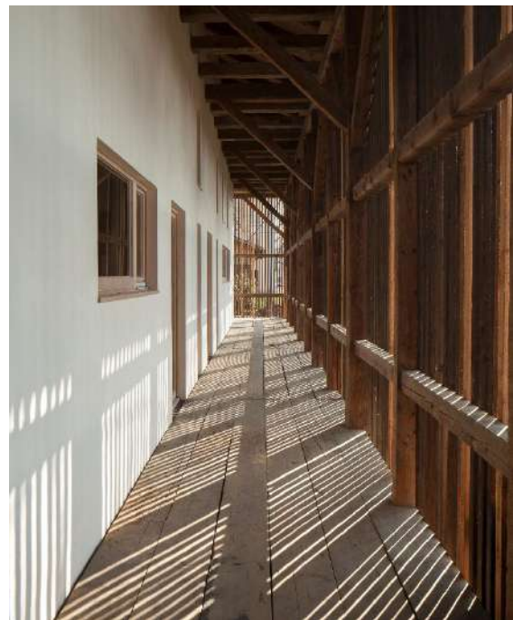
Abbildung 46: Neue Fassade Torfremise 103
