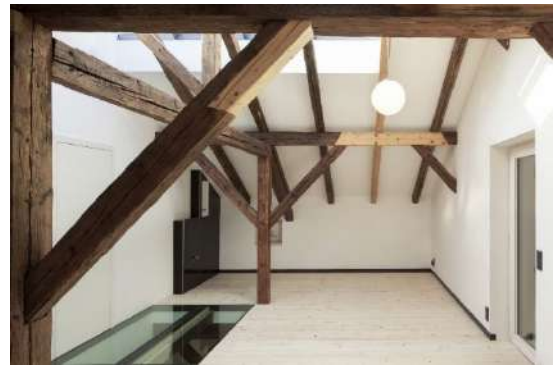
Abbildung 51: Holzkonstruktion im Wiederaufbau 108
