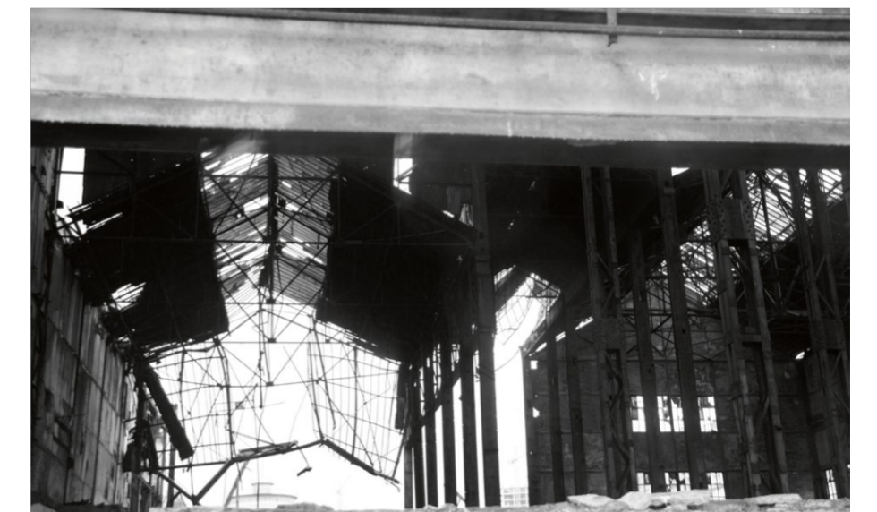
Abb. 4.2.4: Ausblick in den Innenraum vom Norden
