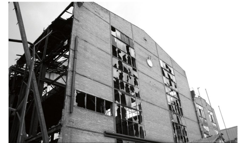
Abb. 4.2.2: Ausblick auf die Fassade vom Süden
