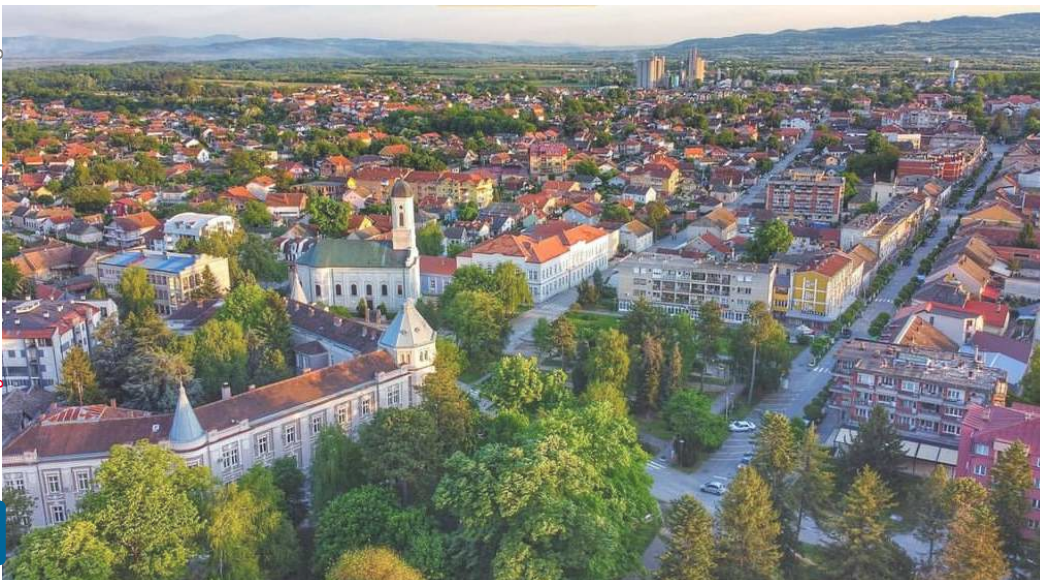
Abb. 2.04: Veliko Gradište, Gemeindezentrum
