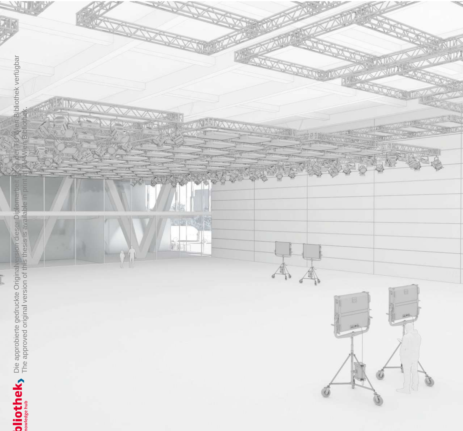
Abb. 105 Eine exemplarische Aufbausituation in einer Studiohalle - gut sichtbar die Traversen-Riggs
