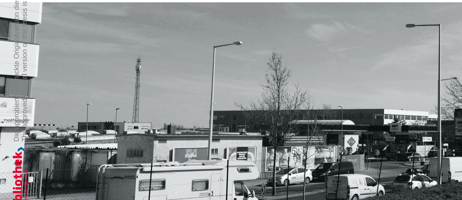
Abb. 45 Blick entlang Brunner Straße Richtung SÜDOST
