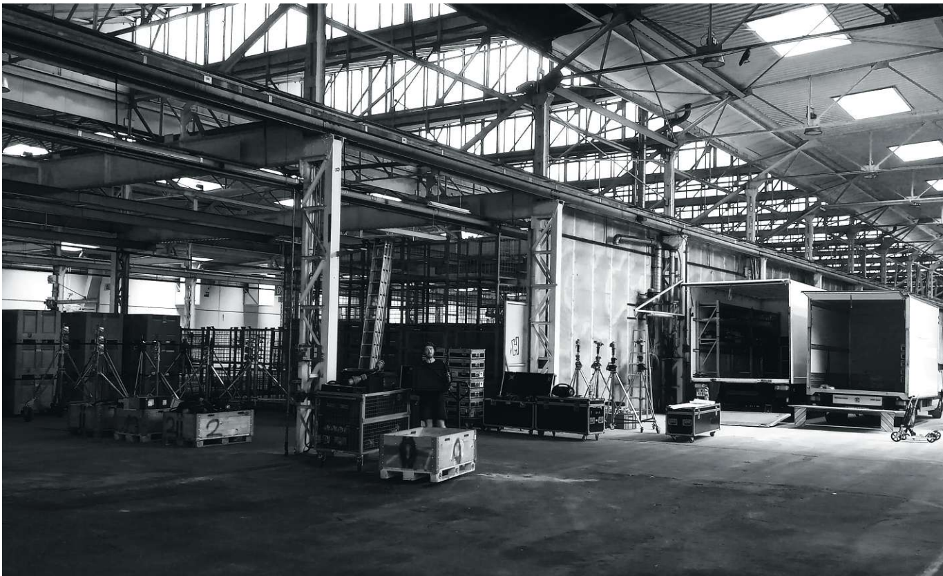
Abb. 08 Vermeidbar - über 4.000 m Strom- & Steuerkabel mussten hier vorab verlegt werden
