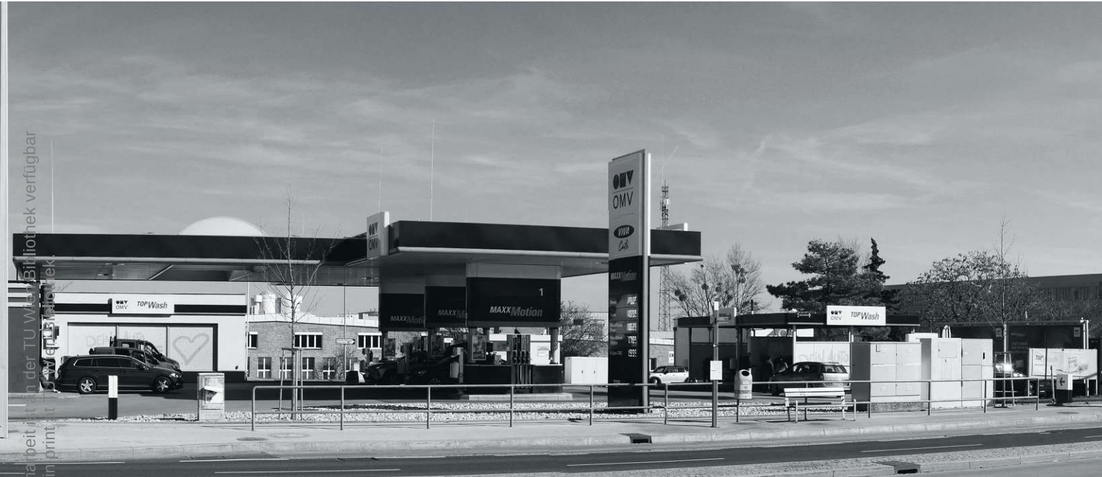
Abb. 44 Blick von Brunner Straße Richtung SÜDOST
