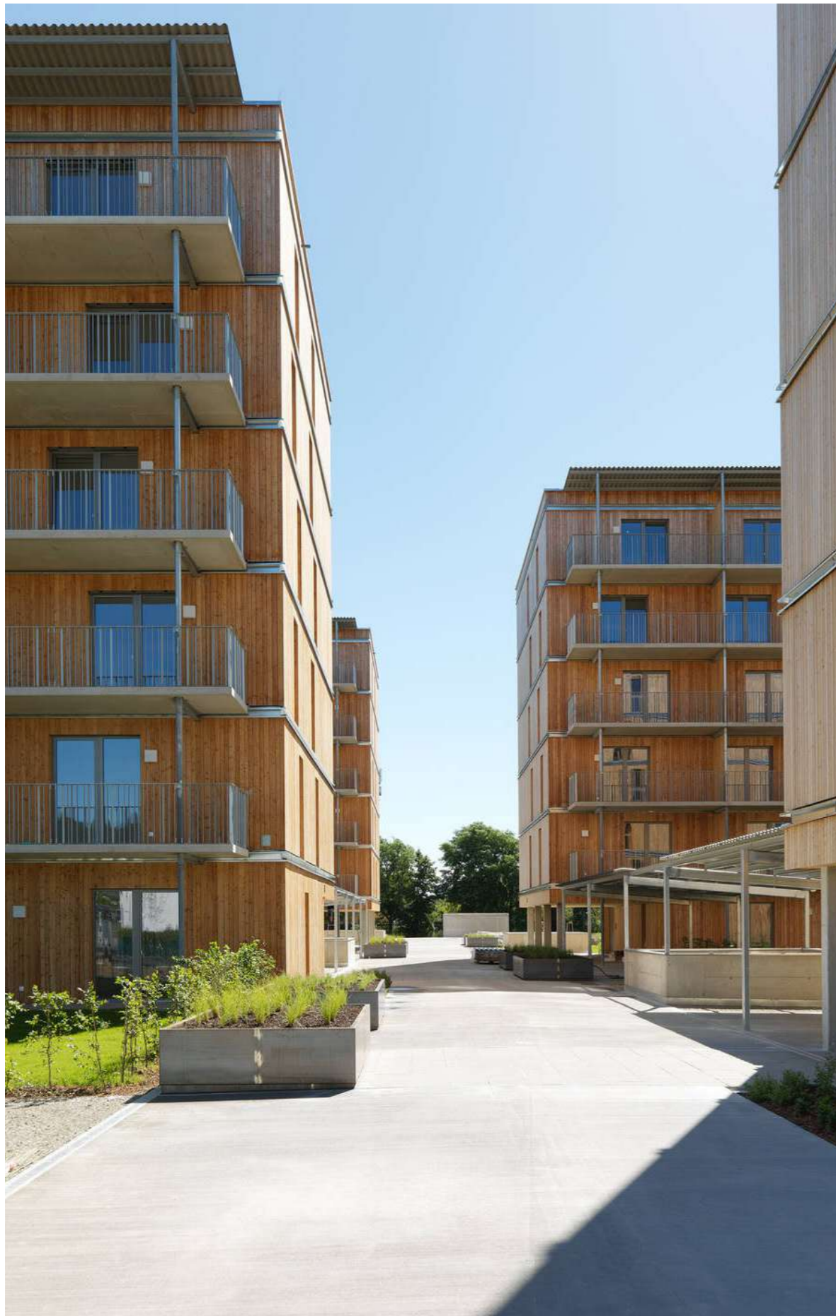
Abb.37 Erdgeschosszone Holzwohnhaus Hummelkaserne
