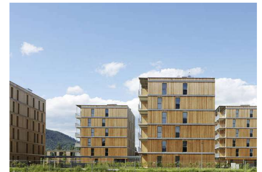
Abb.38 Außenansicht Holzwohnhaus Hummelkaserne
