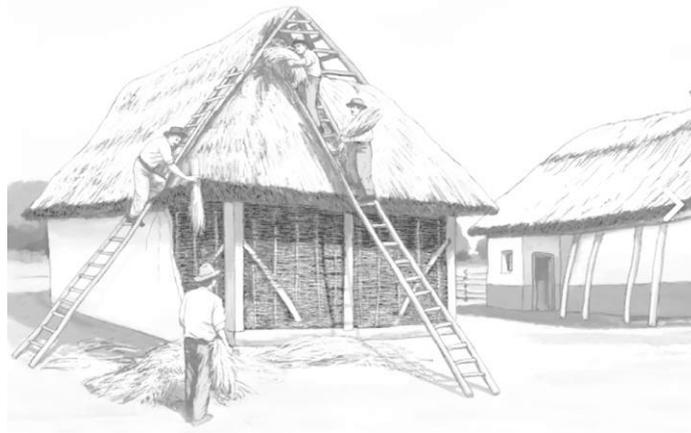
Abb. 39: Bau eines Bauernhauses aus Lehm verputzten Weidenwände und mit Reetdach
