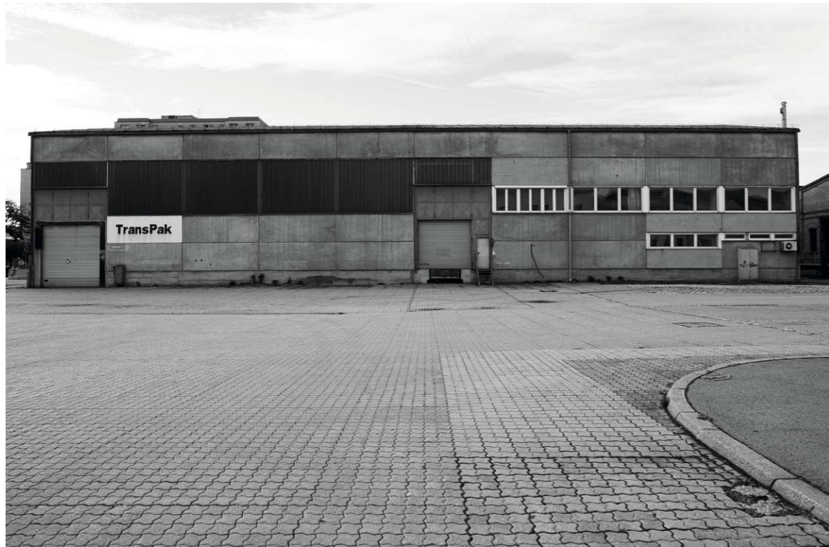
Abb.20: Außenraumfoto der ehemaligen Transpak-Halle
