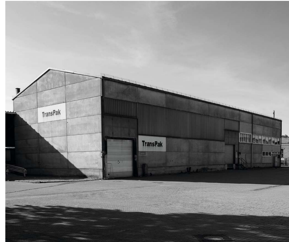
Abb.24: Außenraumfoto der ehemaligen Transpak-Halle
