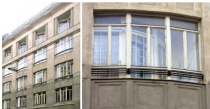
1040, Schleifmühlgasse 3. 1911. Ernst Epstein. Bay Windows mit dahinterliegenden verandaartigen Räumen.
