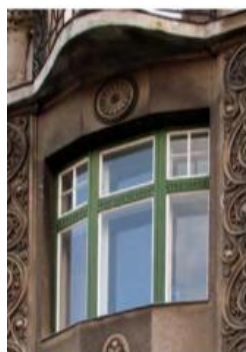
1150, Kriemhildplatz 3. 1914. Bay Window: Oberlichten mit kleinen Quadraten, mittig ursprünglich mit einer Raute.
