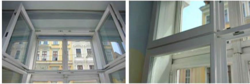
Ansicht der neuen Innenflügel mit Isolierverglasung.
