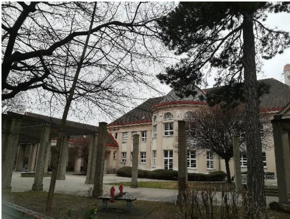
Abb. 94 - Jahr 2018 - Die Reste der Pergola im Kindergartenhof
