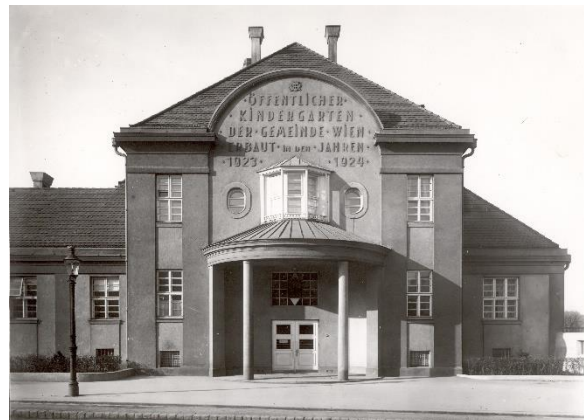
Abb. 87 - Jahr 1925 - Kindergarten – Haupteingang an der Herzgasse
