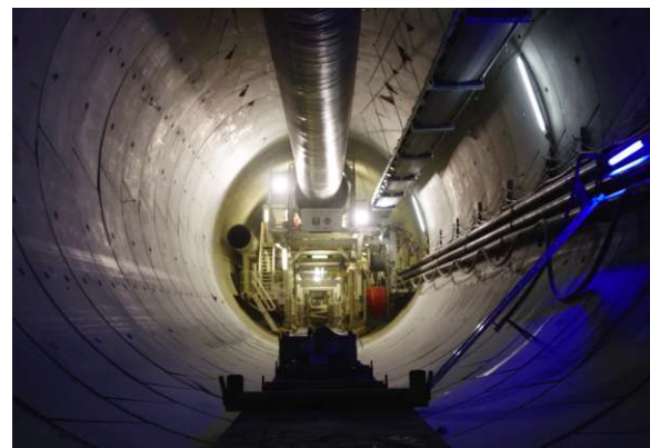
(b) Maschineller Vortrieb im Semmering-Basistunnel © ÖBB
