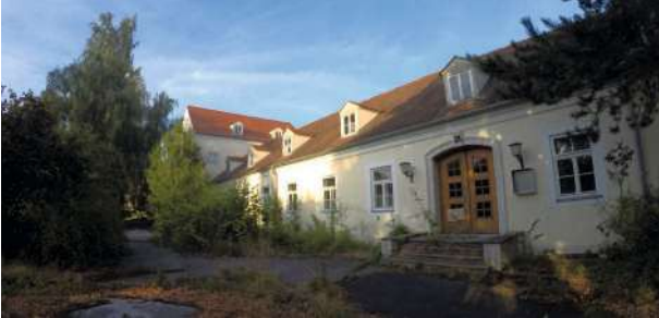
Abbildung 147 Lehrsaalgebäude Eigene Aufnahme. August 2019.
