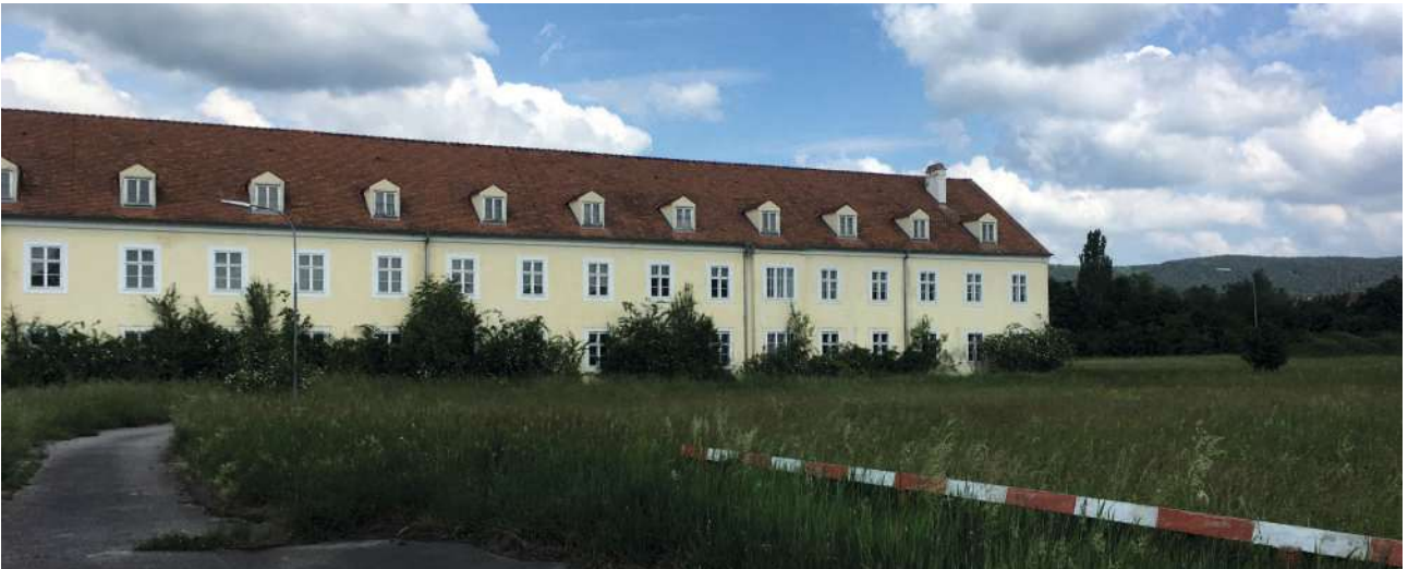
Abbildung 32 Mannschaftsgebäude NORD Eigene Aufnahme. August 2019.
