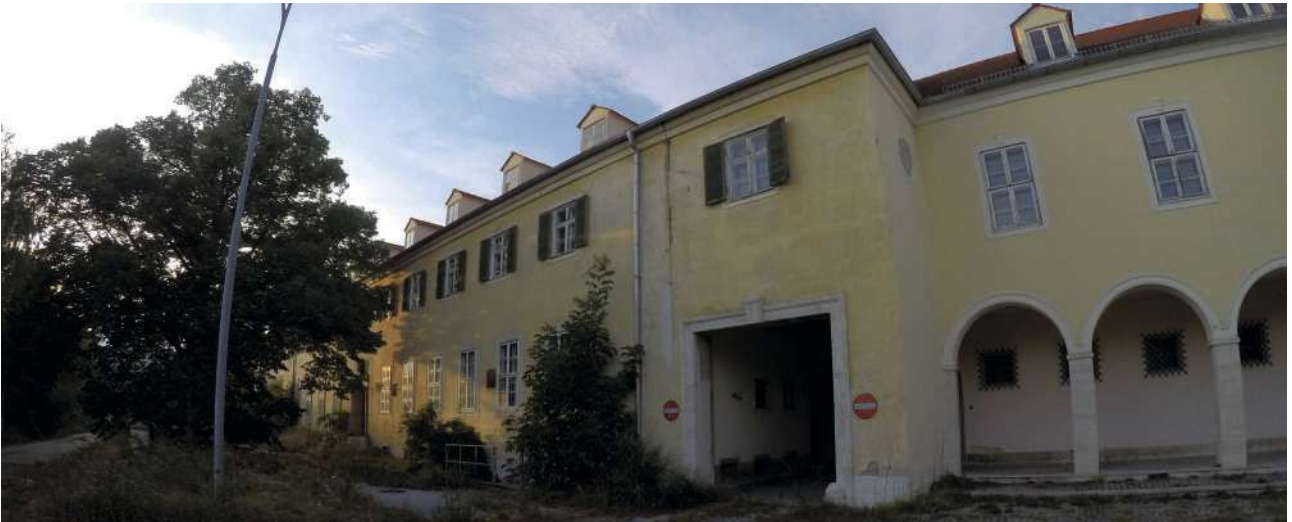
Abbildung 40 Küchen- und Speisesaaltrakt Eigene Aufnahme. August 2019.
