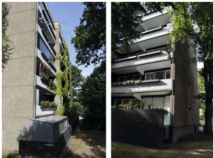
B5 - Südost (l) - Südwest (r) Fassade
