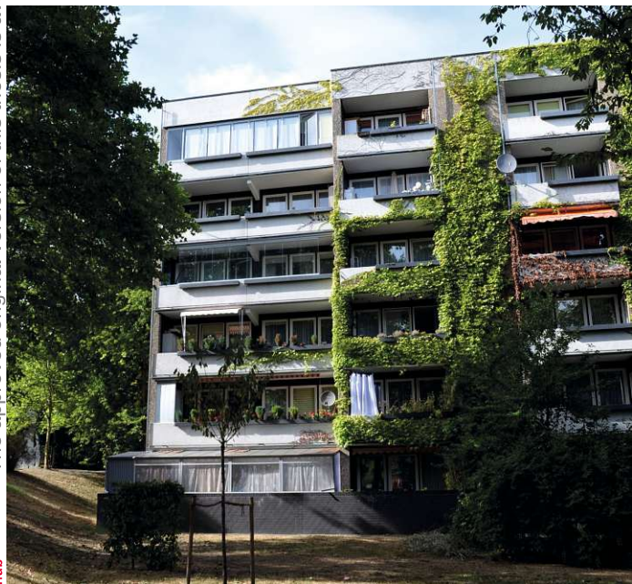
B4 - Süd Fassade
