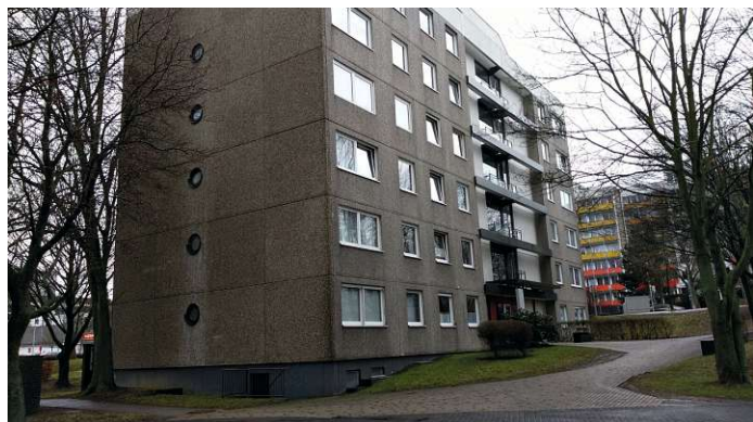
B3 - Nord-Ost Fassade
