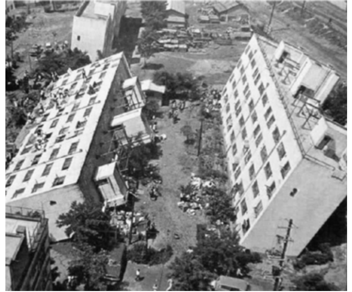
Abb. 108, Liquefaktion in Niigata Japan, 1964
