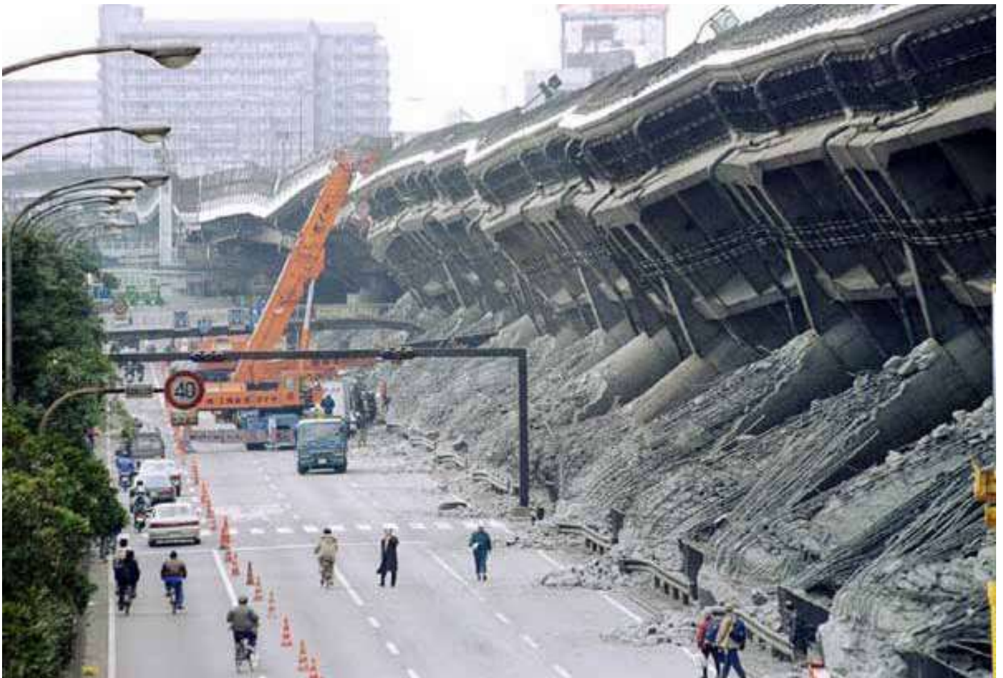
Abb. 113, Gekippte Autobahnbrücke bei Kobe, 1995
