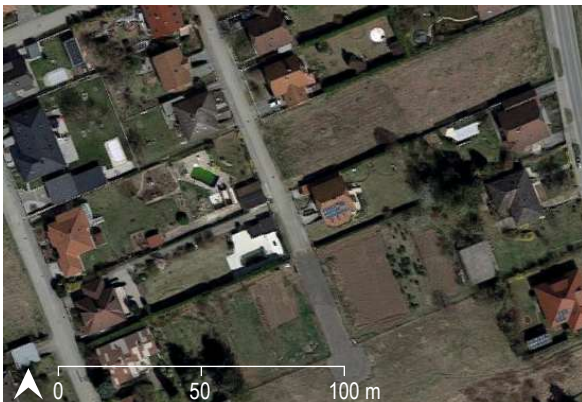
Abbildung 41: Einfamilienhäuser Orthofoto, Quelle: Google Maps, 2023b
