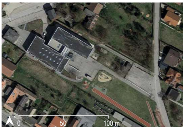
Abbildung 47: Sonderbebauung/Solitär Orthofoto, Quelle: Google Maps, 2023b
