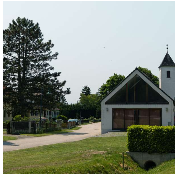
Abbildung 73: Siedlung und Straße in Kiblitz, Quelle: Rabl, 2023
