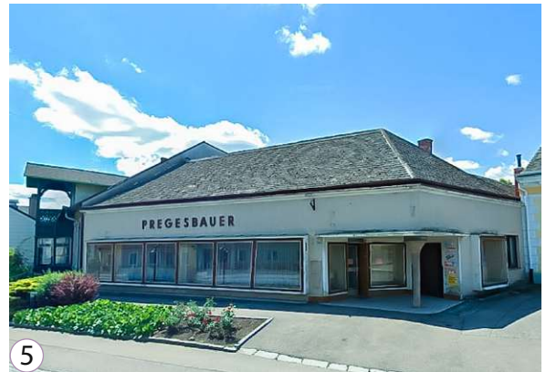
Abbildung 108: Leerstand Horner Straße 19, Quelle: Google Street View, 2021
