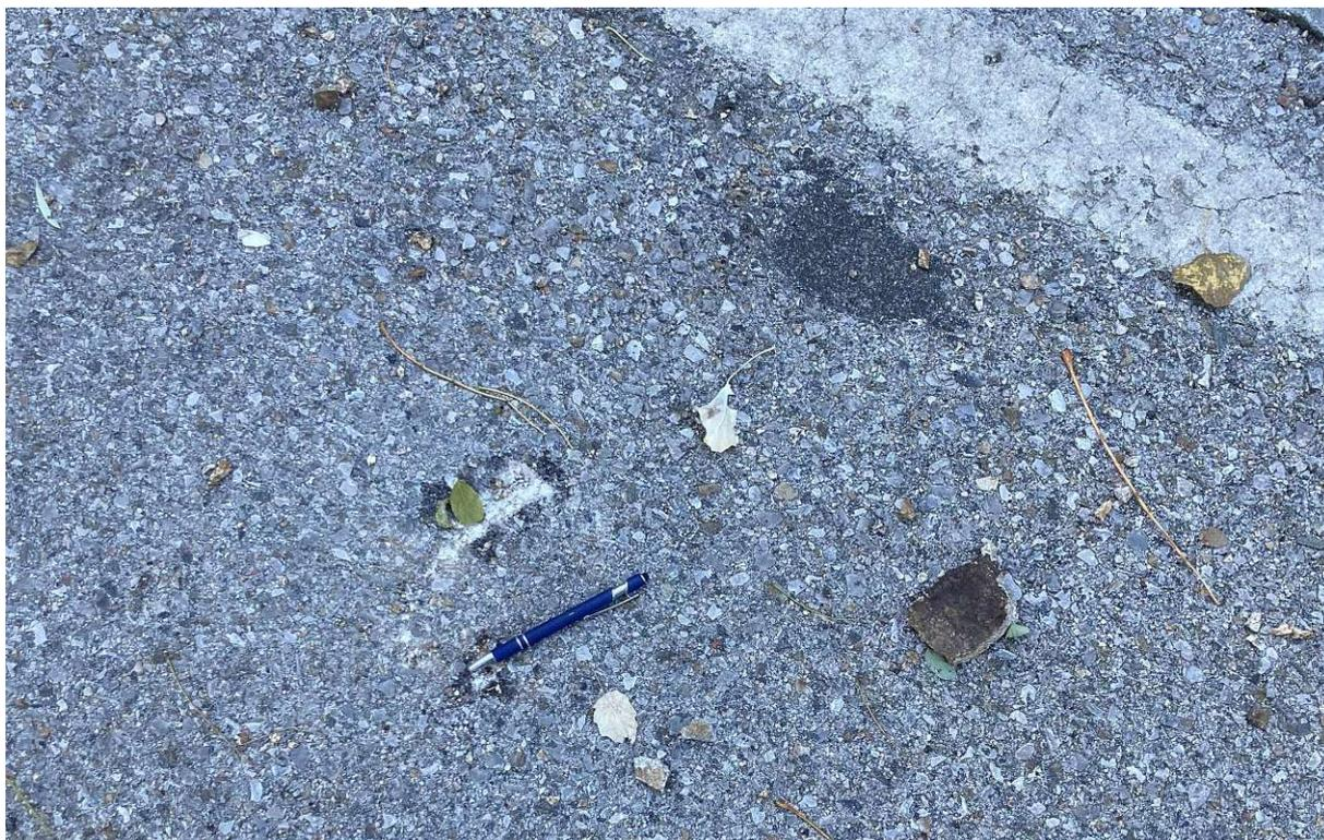
**Abb. 6.12:** Schlagmarke und kleiner Sturzblock entlang der B33
