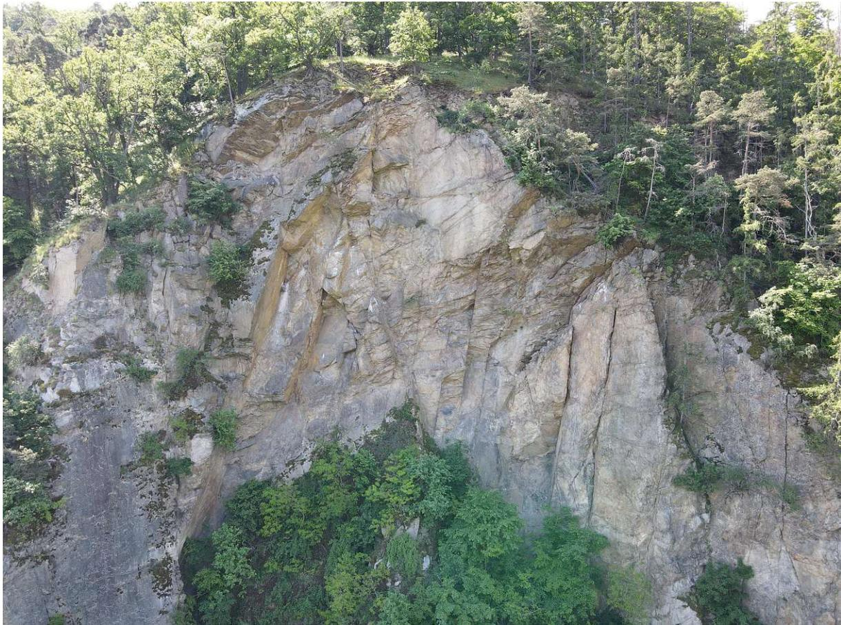
**Abb. 6.10:** Stark zerklüftete Bereich im oberen Drittel der Felswand
