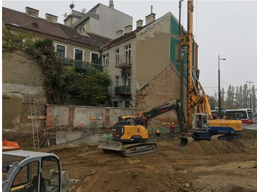
**Abb. 3.14:** Die Arbeiten der Baugrubensicherung zum Nachbargrundstück - rechts im Bild ist das Bohrgerät Typ Bauer BG20H, links im Bild ist der für die unterstützenden Arbeiten notwendige Bagger Volvo ECR145e ersichtlich [45]
