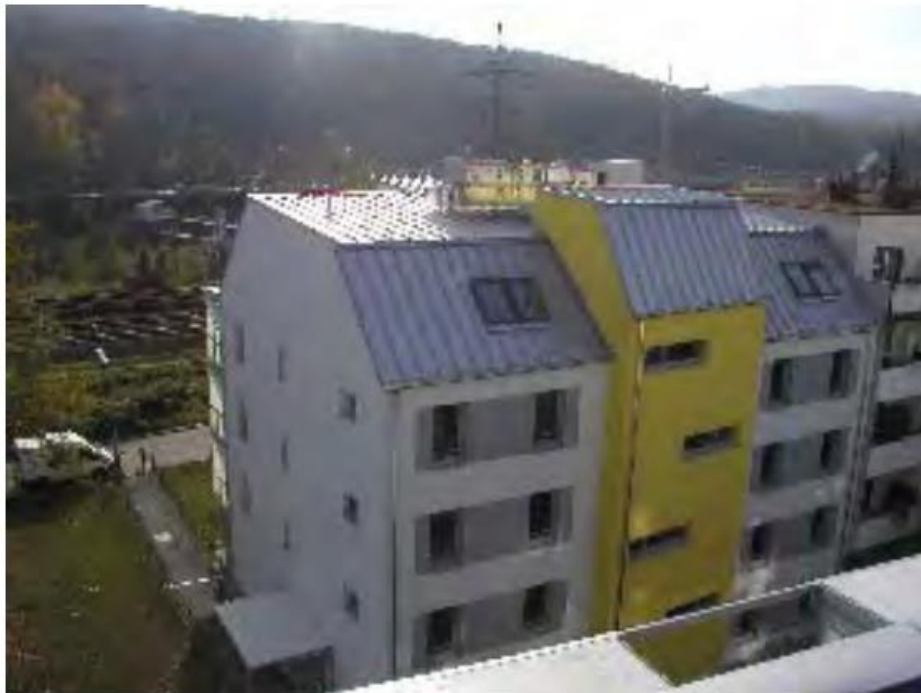
Abbildung 19 : Nordansicht Haus 2 Utendorfsgasse (32)
