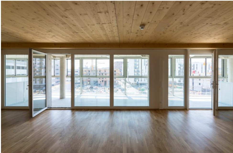
Abbildung 6-9: Bikes & Rails - Südseitige Außenwand zwischen Wohnung und Wintergarten (aus [126])
