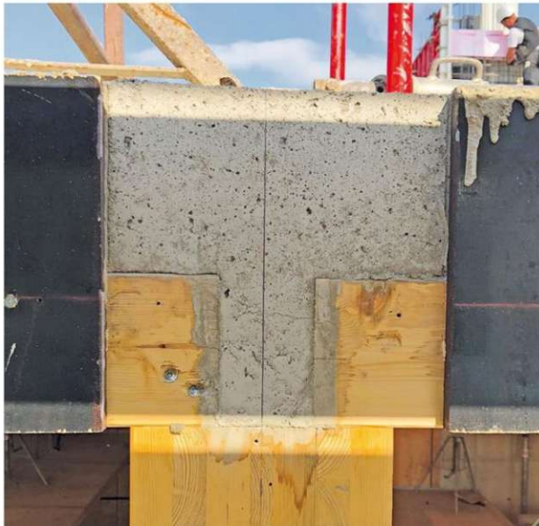
Abbildung 6-16: Walden 48 - Wand-Decke-Wand-Stoß (aus [140])
